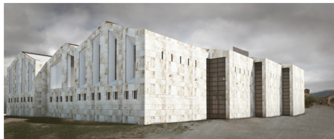
VISTA DE LA FACHADA OESTE
