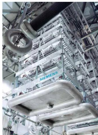
Irudia 4 – Tiristoreak serian konektatuz osatutako HVDC gailua
