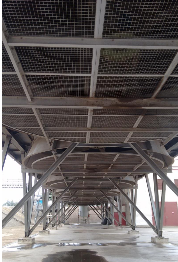
Imagen 45. Aerocondensadores
