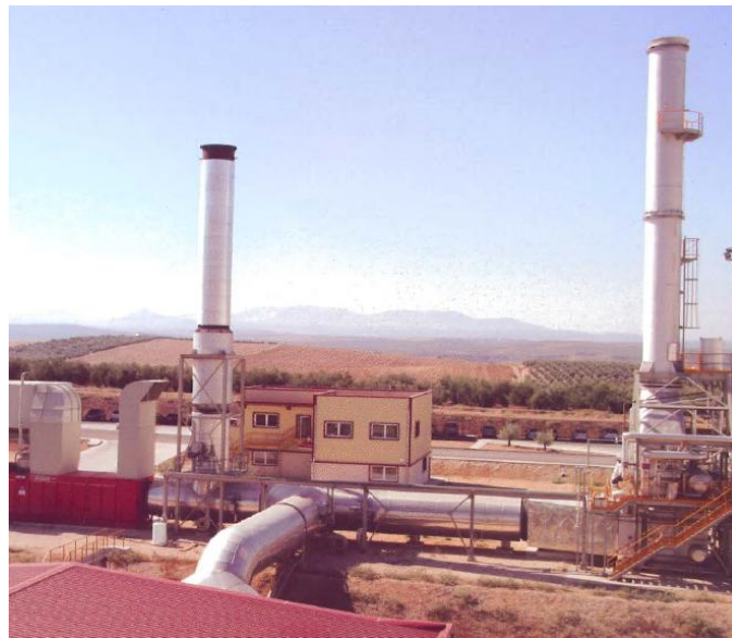
Imagen 33. Turbina de gas, gases a secaderos y caldera de recuperación
