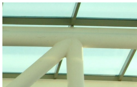
3.3. irudia: Giltzadurak: ezkerrean, Eibarko Astelena frontoiko estaldurako eraikuntza-detailea; eskuinean, Donostiako Fatronik-Teknalia ikerkuntza-zentroan hodiz osatutako egitura
