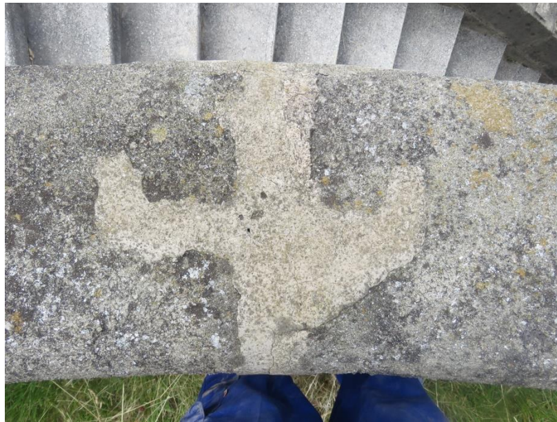
Figura nº 21. Grapas de unión de los barandales superiores en el tramo 35*.2019.
