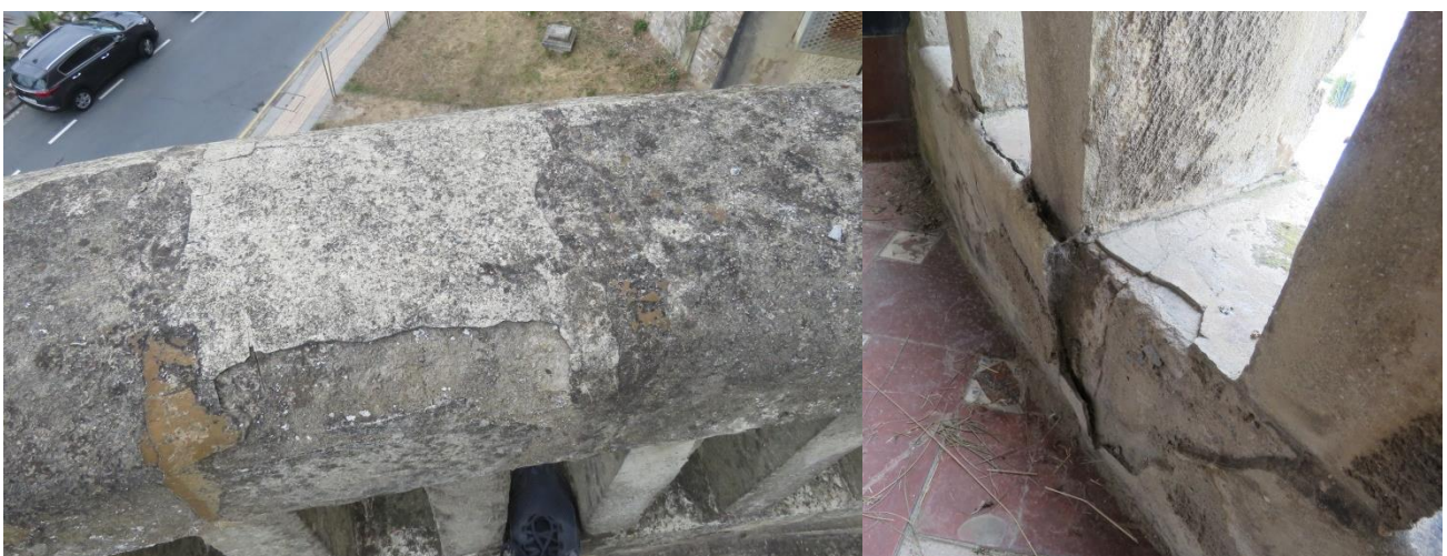
Figuras nº 22 y 23. Restos de mortero de recubrimiento en la zona superior del Tholos y en la galería NW. Grupo B.B.A.A. 2018.
