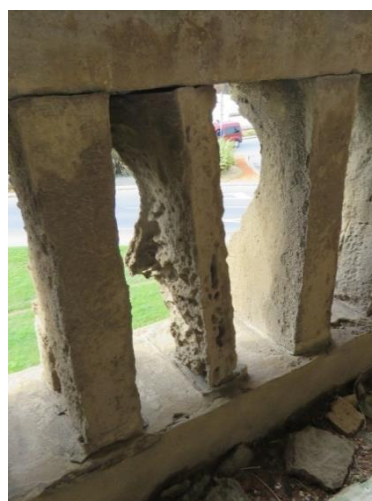
Figura nº 51. Alveolización en un balaustre del modelo A. Tramo 34* Nivel 1 Balaustre 11.
