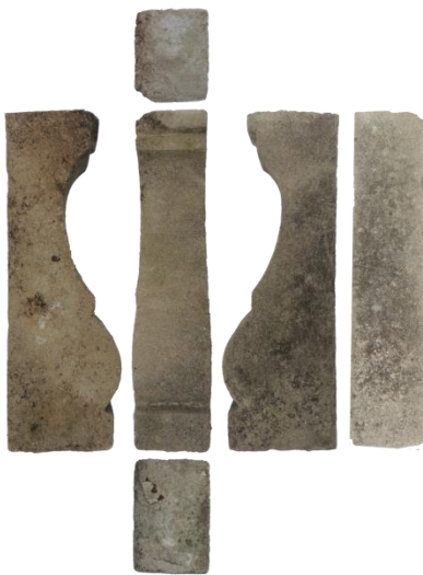
Figura nº 27. Despiece fotográfico de todas las caras de un balaustre del modelo B.2018
