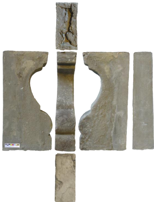
Figura nº 14. Despiece fotográfico de todas las caras de un balaustre del modelo A. 2018.
