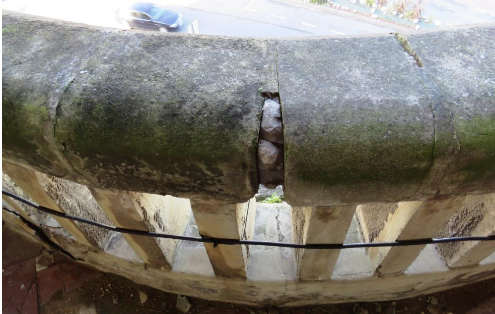
Figura nº 24. Relleno de mortero para poder realizar el giro. Galería NW. Grupo B.B.A.A
