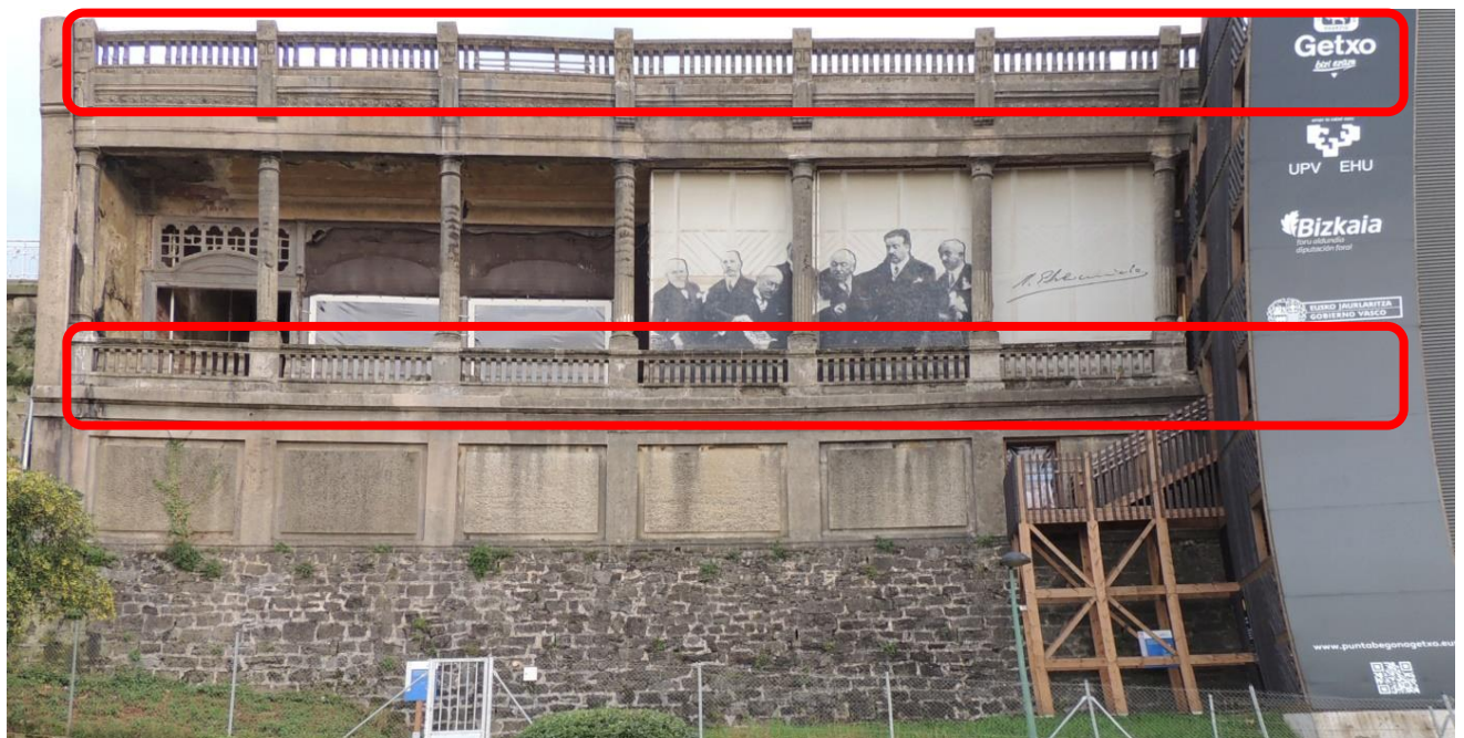
Figura nº 12. Fachada del salón con la balaustrada modelo A remarcada. 2018.
