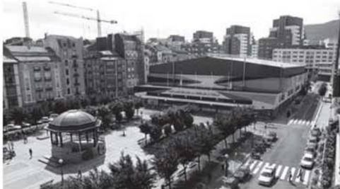
1._La Casilla Plaza
