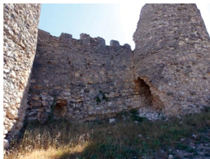
Figura 23 Torre T7. Es visible, en la zona derruida, la independencia de la torre del lienzo de muralla (A. Sainz 17/06/2014)
