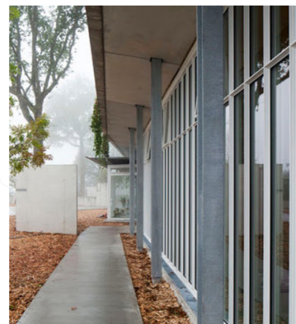
7 Fatxada une oro hegalkin baten babespean egongo bada ere, lurretik etor daitezkeen ura jasoko duen luzetarako estolda-zuloa izango du ertz osoan zehar.
