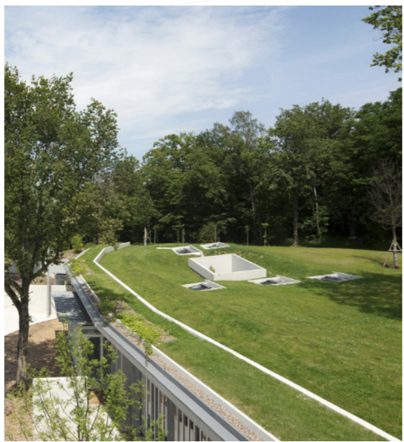
2 Bai interpretazio zentroaren instalakuntza gelaren gaineko estalkian bai ikerlarien aterpetxean sukaldearen gainean zuloak azalduko dira tximinoa moduan.
