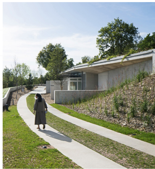
1 Eraikinetara doan bideak hormigoizko filtragarriko bi zinta izango ditu eta erdian lur konpaktatua zuloak sailhesteko maila berdintzaile batekin.
