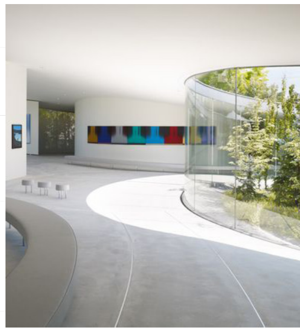
5 Kanpoko materialari jarraiki eraikinaren barnean ere hormigoizko txuria proposatzen da. Jarrailasun bisuala lortzeko gain, zoru erradiazioa izanik akabera material aproposa da, inertzia altuko.
