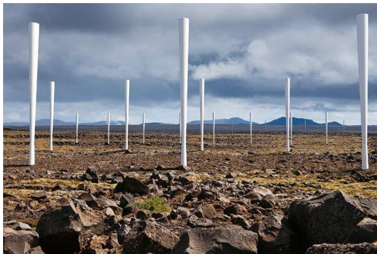
Irudia 4-1. Vortex Bladeless aerosorgailuen egitura bat.
