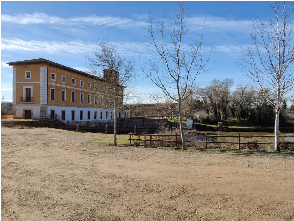
Parte posterior de las compuertas.
