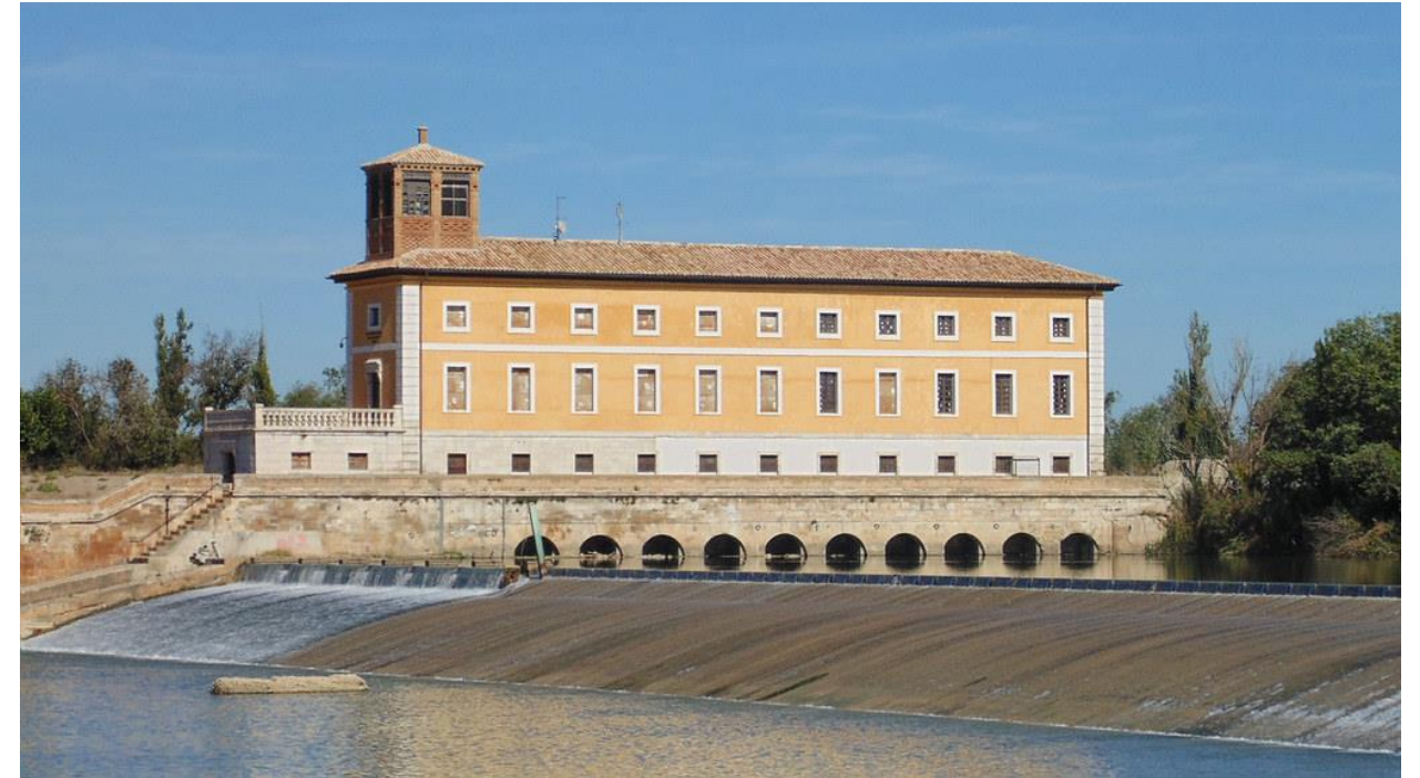
Edificio de compuertas y la presa.
