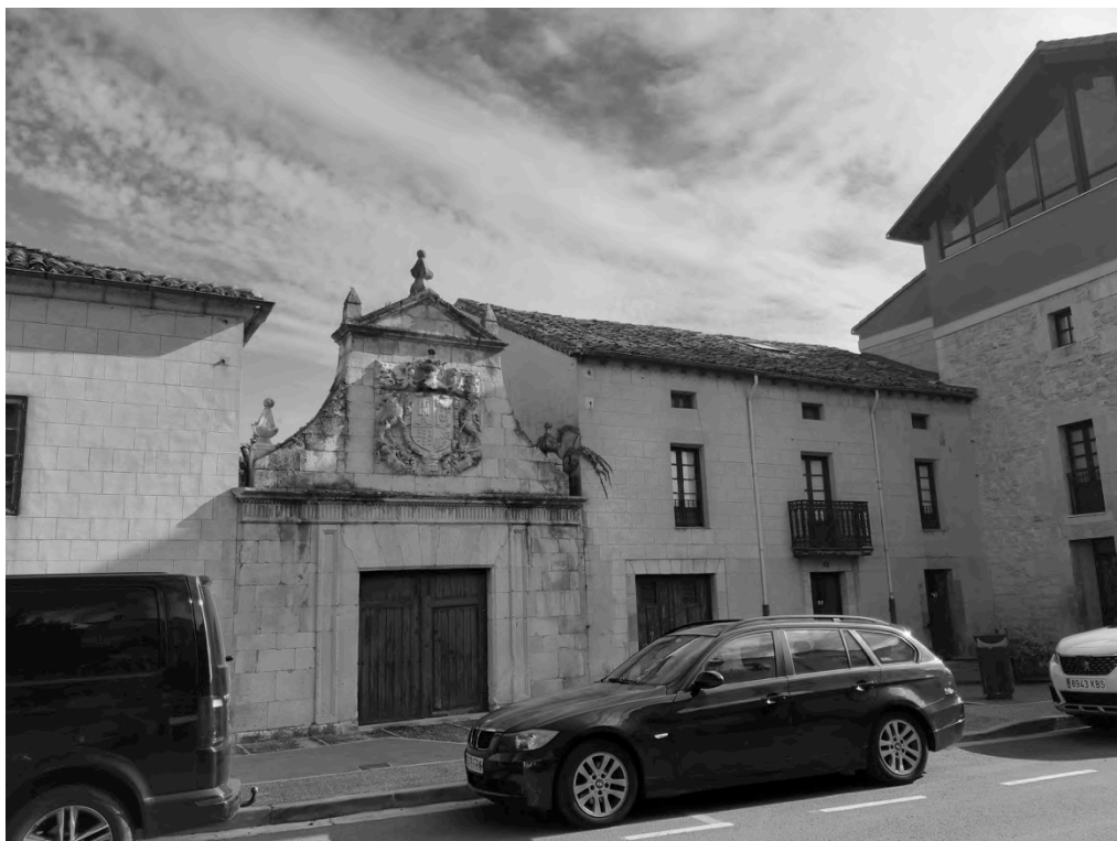
Imagen 18 – Conjunto casonas Fuente: Elaboración propia
