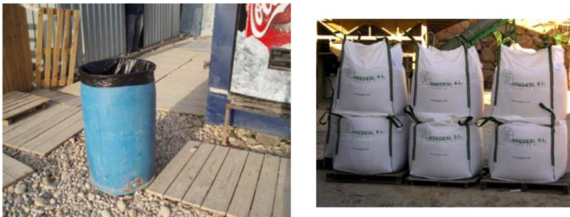
Imagen 19: Contenedor y sacos reciclables de recogida de RCDs. [15]
