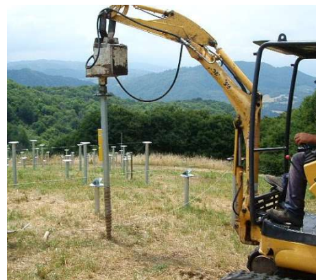
Ilustración 11 Tipos de tornillos de cimentación e instalación con una simple excavadora
