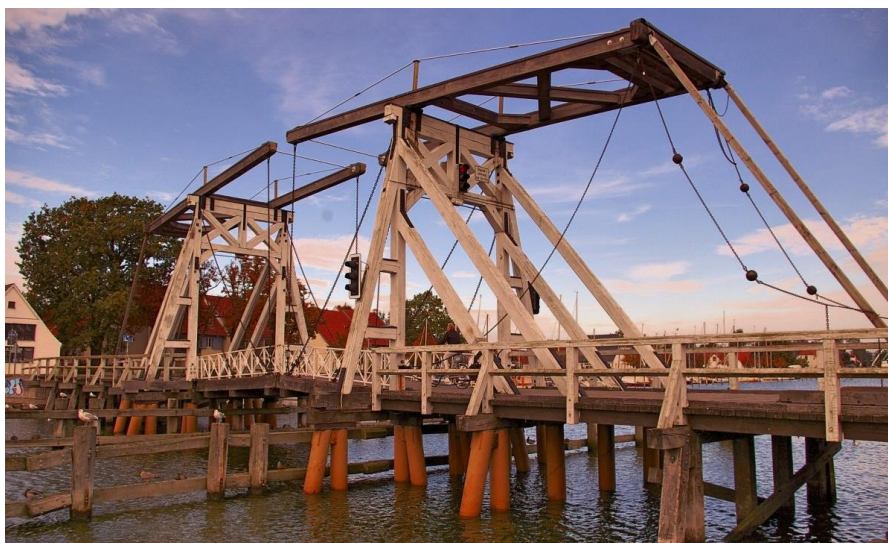
Ilustración 5.2 - Antiguo puente levadizo de madera, Alemania
