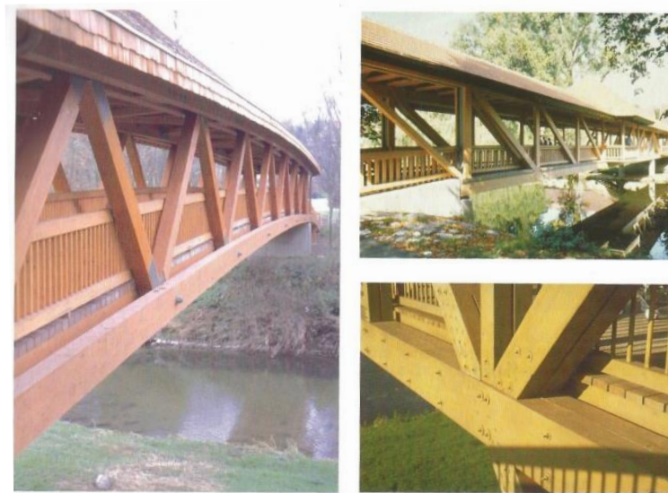
Ilustración 5.23 - Barandillas en el interior de la estructura
