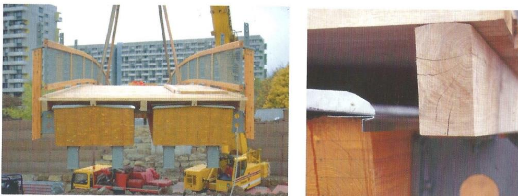
Ilustración 5.27 - Vigas de un puente protegidas con una chapa continua, Stuttgart (Alemania)
