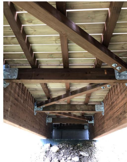
Ilustración 7.10 - Elementos secundarios en el modelo de viga simple
