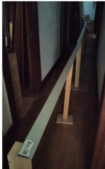
Figura 82. Montaje preliminar de la construcción del sistema de barandillas.
