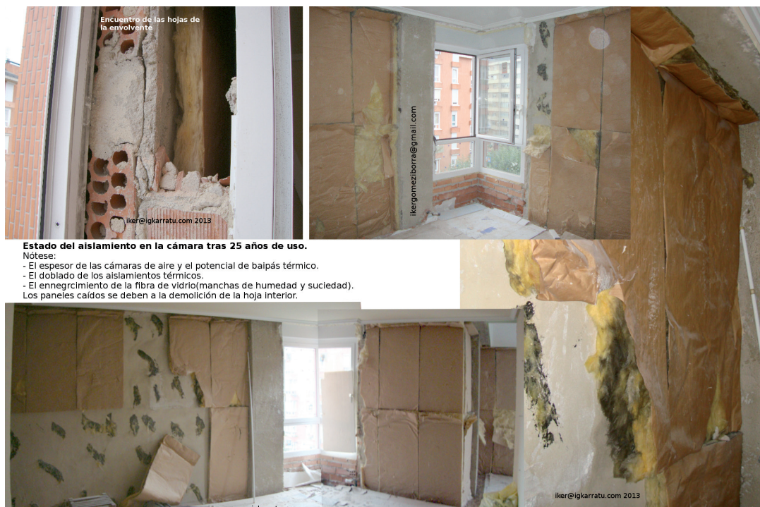
Fig. 2: Imágenes de las cámaras "no ventiladas", estado del sistema aislante, manchas de humedad y problemas de estanqueidad.
