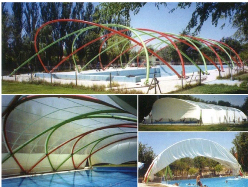
F. Escrig y J. Sánchez, cubierta desplegable para una piscina semiolímpica en Valencina de la Concepción, Sevilla (Escrig 2012)
