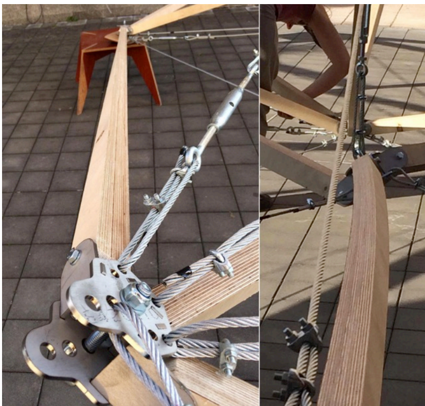
Giros de los nudos en la primera prueba de montaje debidos a la insuficiente rigidez a torsión de las barras
