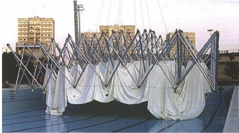
Cubierta de la Piscina del Complejo San Pablo, Sevilla, proceso de montaje. (Escrig 2012)
