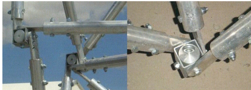
Nudo empleado en una piscinas particular en Sevilla (Escrig 2012).
