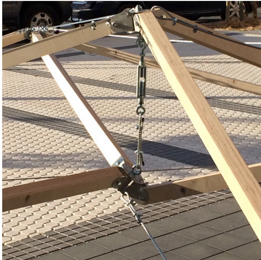
Estructura desplegable de nudos de tres barras. Algunos nudos de tres barras con cargas asimétricas son inestables
