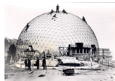
Estructura geodésica construida por Walther Bauersfeld, Jena 1922 Fuente: http://www.zendome.de
