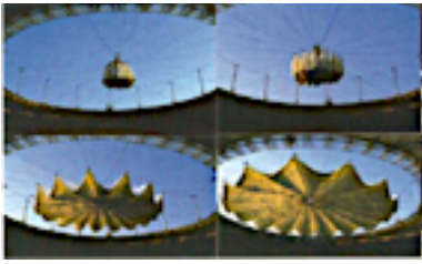
Cubrición retráctil textil para el Plaza de Toros de Zaragoza, G. Schlaich 1990. (Escrig 2012 ).
