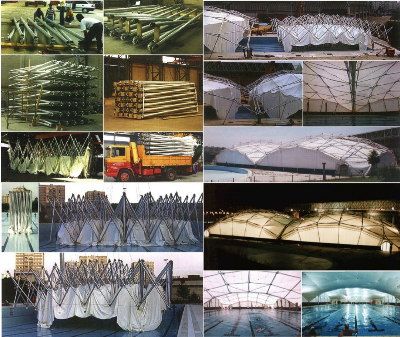
Secuencia de fabricación montaje y resultado de la cubrión de la Piscina de San Pablo (Escrig 2012)
