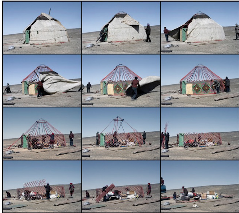
Proceso desmontaje de una yurta Kazaja . Cuenca de Dzungaria. Fuente: J L Mejías
