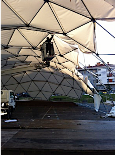
Har-etxea , montaje de la cubrición Errenteria 2012
