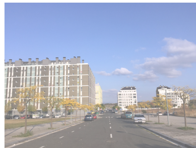
FOT. 14 CALLE ITINERARIO DE ANTONIO, PROXIMIDADES DEL SOLAR
