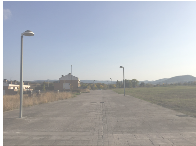
FOT. 17 CALLE DE ALBA, DELIMITACIÓN DE LA PARCELA POR EL ESTE
