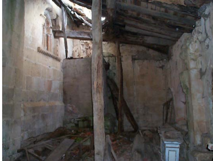
segunda parte del pórtico
