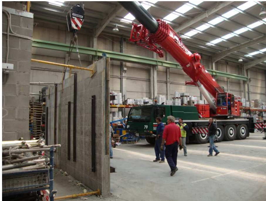
Figura 4.7: Vuelco de la estructura mediante grúa.
