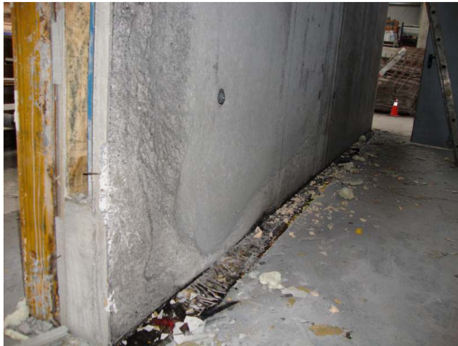
Figura 4.5: Forma moldeada por la presión de bombeo en el extremo de la manguera.
