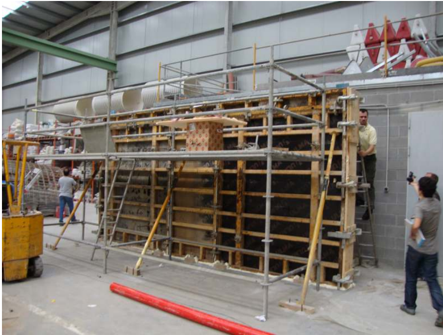
Figura 4.2: Vista del encofrado y las juntas selladas.
