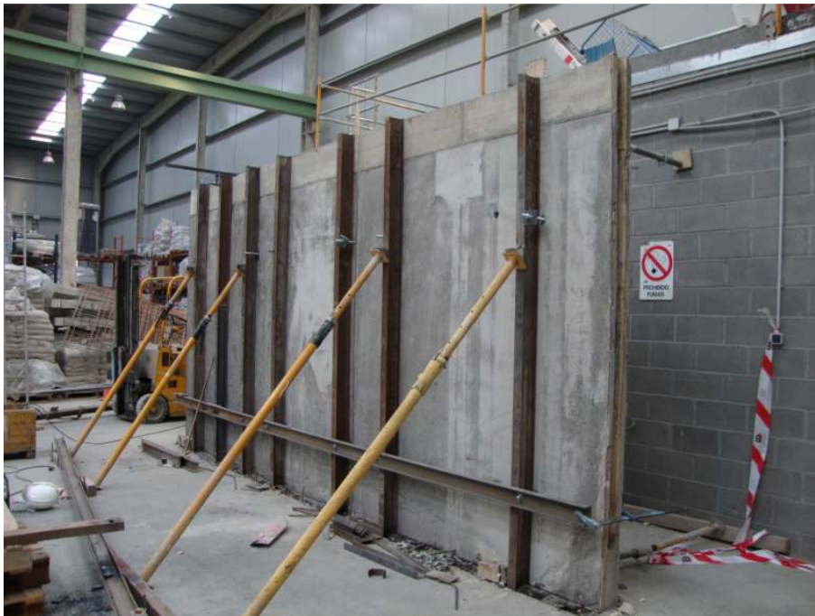
Figura 4.4: Vista del muro tras su desencofrado.
