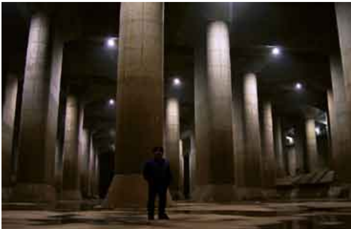
G-Cans. Infraestructura para el alcantarillado. Tokio.
