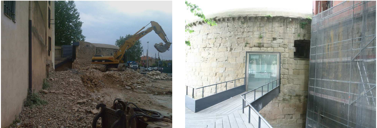
Fig. 1.- Derribo del frontón en mayo de 2009 e imagen del tramo de muralla andamiado durante su restauración.
