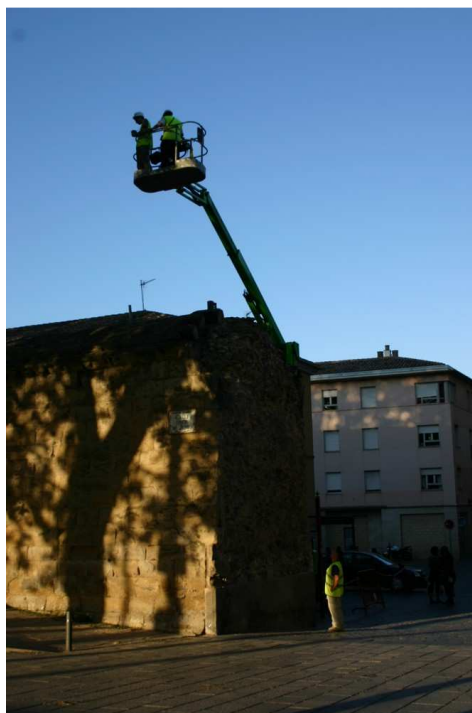
Fig.13.- Obtención de pares fotogramétricos de la zona superior de la muralla.
