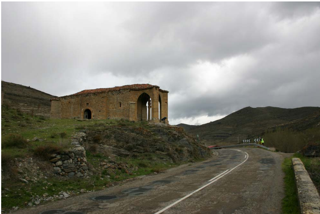
Fig. 1.- Vista del edificio durante las tareas de documentación geométrica en 2005.
