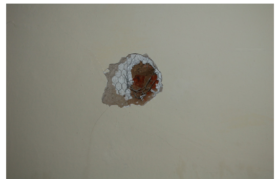
Fig. 4. Detalle de aislamiento de poliestireno expandido y malla de gallinero.
