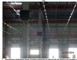
2. Aerolermos protegidos frente al polvo mediante la colocación de plástico en nuelles de zona norte
