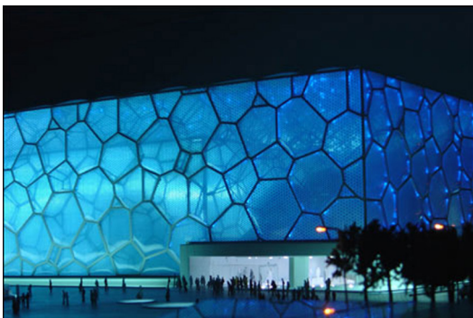
Fig. 3. Edificio Water Cube, Pekin (Fuente: www.jetsongreen.com ).
