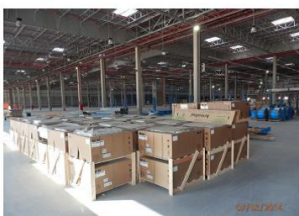
1. Acopio de aerolermos para climatización de nave, en su embalaje original hasta su instalación
