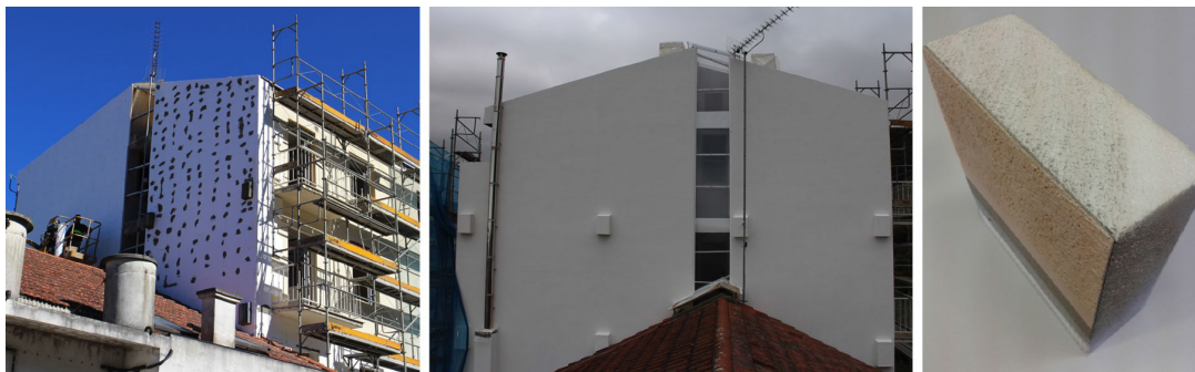
Fig. 5. Sistema de fachada SATE aplicado en edificio de viviendas.
