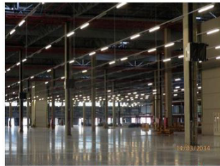
2. Tapado de aerolermos para su protección frente al polvo en zona central de nave
