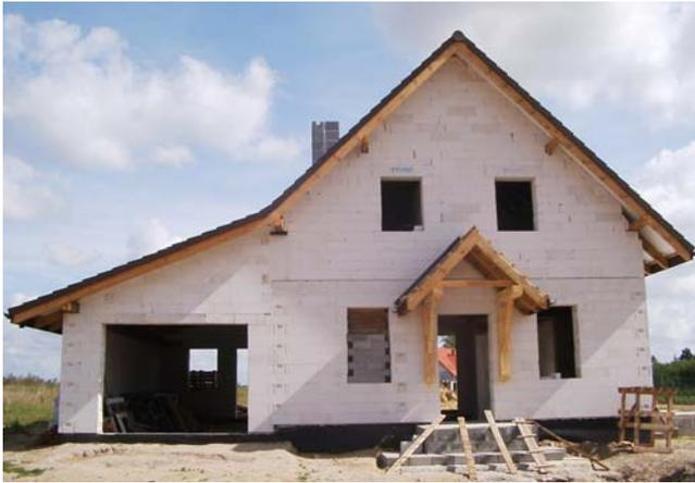
Fig. 34. En edificios de poca altura, con exigencias mecánicas reducidas es cada vez más frecuente la utilización de cerramientos estructurales constituidos por una sola hoja. La mayor dificultad reside en la interacción del sistema de cerramiento con los elementos estructurales horizontales e inclinados. En la fotografía, vivienda realizada con cerramientos estructurales ejecutados con piezas de mortero aligerado.
