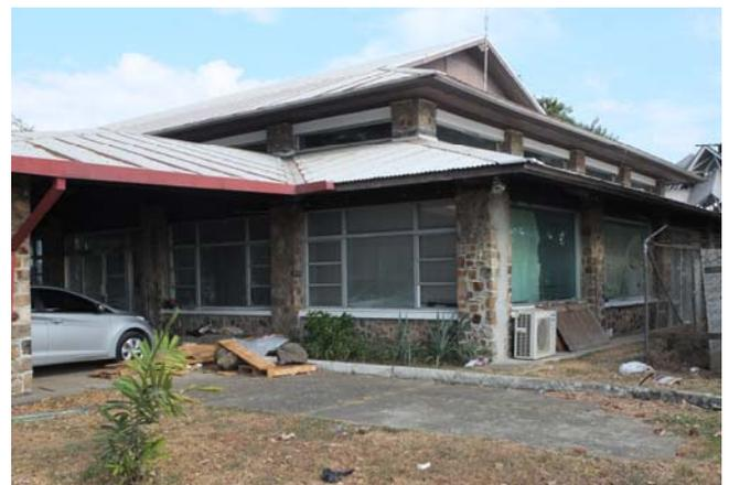
Fig. 42. En las regiones tropicales son habituales las cubiertas ligeras con cobertura exterior metálica y espacio ventilado entre ésta y la hoja interior del cerramiento. La imagen corresponde al edificio del actual Museo de la Diversidad en Ciudad de Panamá. El nuevo edificio, de Frank Gehry.
