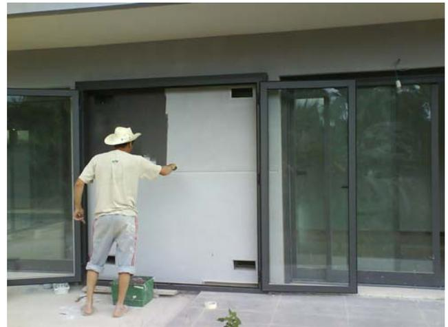
Fig. 38. La imagen muestra la ejecución de un sistema Trombe en un edificio existente. La solución, mediante una carpintería accesible encarece el sistema; aunque lo hace accesible para tareas de limpieza, mantenimiento y es la más viable para edificios existentes. (<http://www.ison21.es/2009/09/09/el-muro-trombe-diy-gallery/>)
