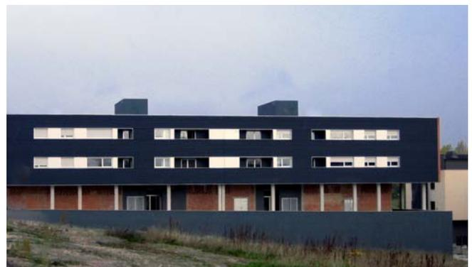
Fig. 16. 78+12 VPO en Sarriena, Pamplona. Fachada ventilada activa orientada a sur. El aprovechamiento de la energía solar permite reducir un 8% el consumo de energía en calefacción.
