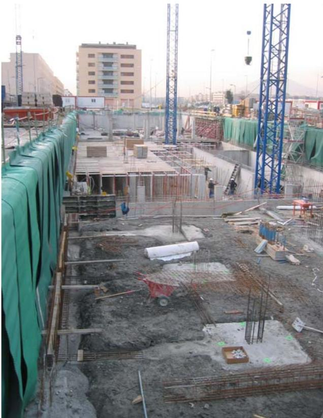
Fig. 41. Los cerramientos con el terreno tienen una elevada estabilidad térmica que puede ser utilizada para compensar las variaciones térmicas de la parte del edificio en contacto con el ambiente exterior. Aunque se han probado diferentes sistemas, todavía no existen protocolos y procedimientos reconocidos para su utilización eficiente.
