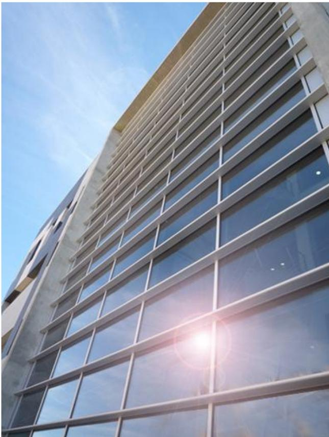
Fig. 58. Muro cortina compuesto por vidrios activos de cámara de agua. Aulario Polivalente en el campus de la U.C.L.M., Cuenca, 2010.
