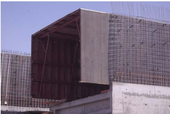
Fig. 35. La utilización de sistemas con grandes encofrados desplazables permite obtener ritmos de obra elevados, pérdidas de material escasas y una elevada reutilización de los elementos auxiliares. Encofrados de tipo tunel.
