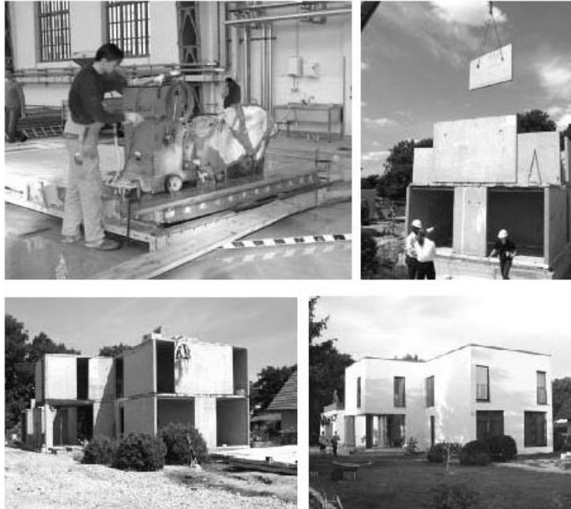
Fig. 5. Reutilización de componentes de hormigón prefabricado. Viviendas. Alemania, 2001. Fuente [9]
