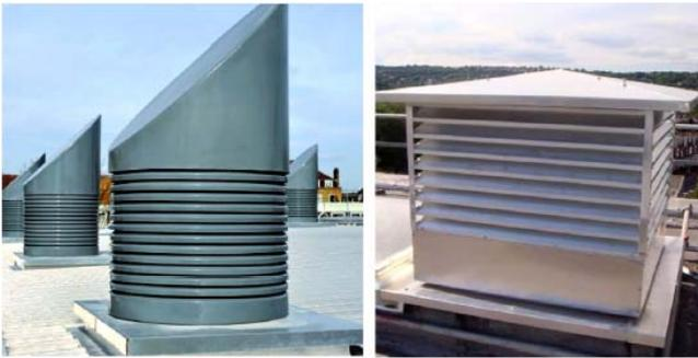
Fig.33. Captador de viento de sección circular y cuadrada [73 y 74].
