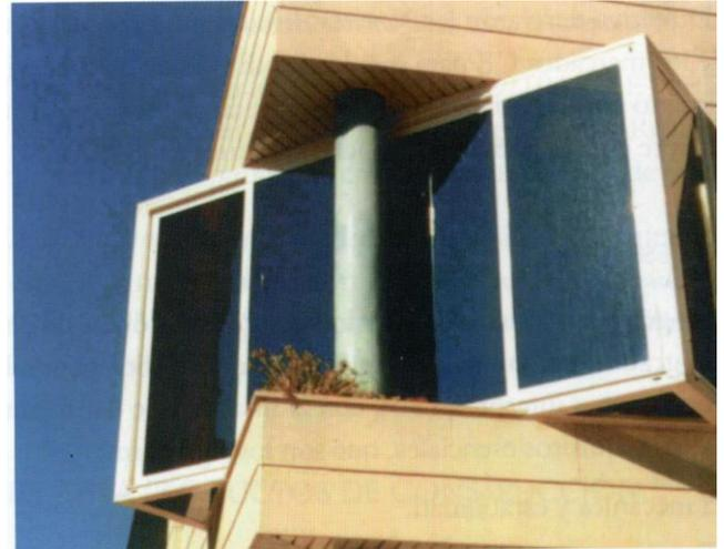
Fig. 53. Sombras arrojadas sobre un acristalamiento por elementos constructivos externos.
