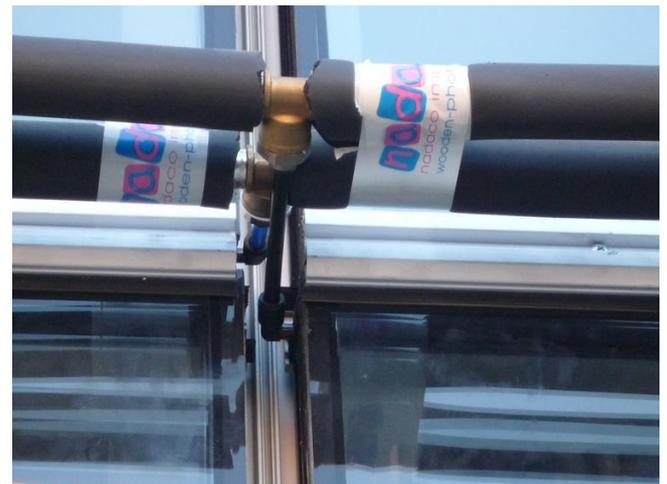
Fig. 60. Detalle de los circuladores que aparecen en la Fig. 59 en el muro cortina del Aulario Polivalente en Cuenca, 2010. Figura extraída de: [http://www.intelliglass.es/index.php?option=com\\_content&view=article&id=118](http://www.intelliglass.es/index.php?option=com_content&view=article&id=118)
