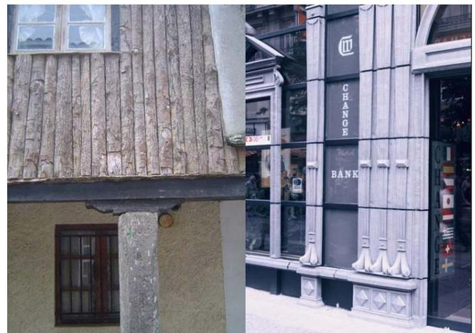
Fig. 21. Fotografías comparadas de revestimientos de fachada distintos pero sincrónicos: troncos de madera (Galicia) y piezas prefabricadas de aluminio fundido (Viena). Fuente propia.
