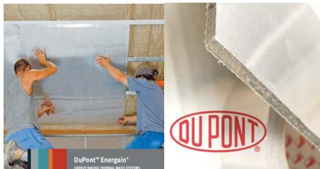
Fig. 12. Energain consiste en paneles en cuyo interior se encuentra un material de cambio de fase atrapado por un copolímero “gomoso”. Las superficies del panel son finas láminas de aluminio. La manipulación e instalación son extremadamente sencillas. (Imágenes e información propiedad de Dupont Energain <http://energain.co.uk/>)
