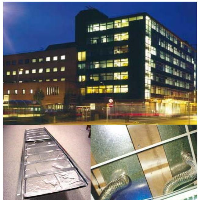
Fig. 5. Daneshill house (Stevenage, UK), en cuyo interior se instaló un sistema de refrigeración con PCM (Cooldeck, Climator) en el proyecto REVIVAL (2002-2006) (Imagen propiedad: <http://www.constructingexcellence.org.uk>)
