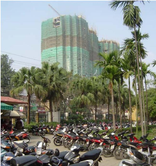
Fig. 10. Fotografía de edificio en construcción en Hanoi (Vietnam) con andamios de bambú. Fuente propia.
