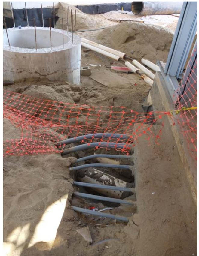
Fig. 44. La utilización de los cerramientos horizontales con el terreno para almacenar calor constituye una opción real. No obstante deben considerarse los inconvenientes de integrar y vincular sistemas cuya vida útil puede resultar muy dispar y en su caso establecer procedimientos para la rehabilitación o sustitución de los sistemas dañados u obsoletos. Redes de conductos integrados en una placa de cemento.
