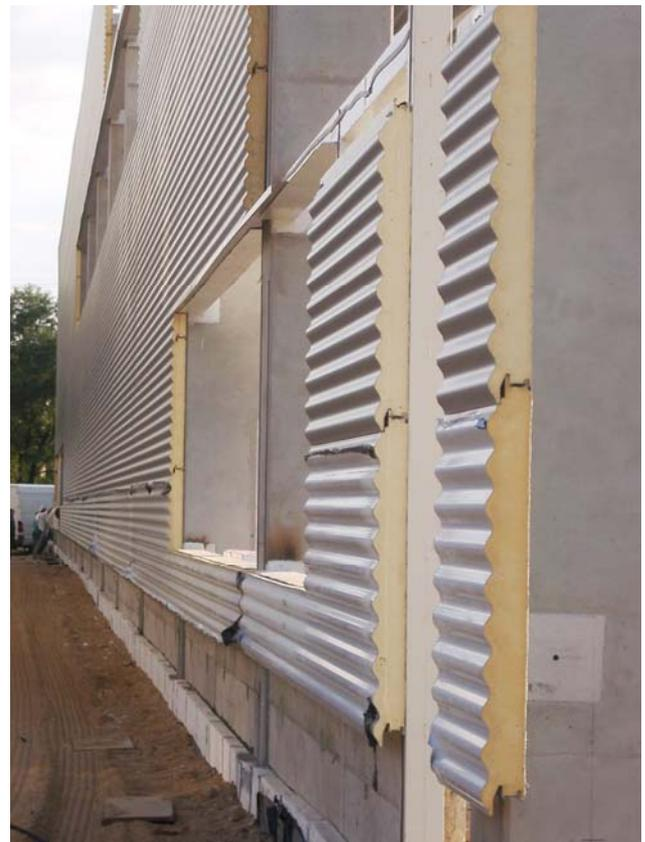
Fig. 21. Edificio industrial en la ciudad de Broclav en el que puede apreciarse el aislamiento de todos los cerramientos, incluyendo el de los cimientos.
