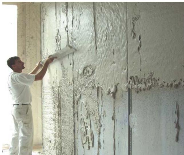
Fig. 10. Modo de aplicación del mortero con PCM. (Imagen propiedad de Micronal –BASF: <http://www.micronal.de/>)
