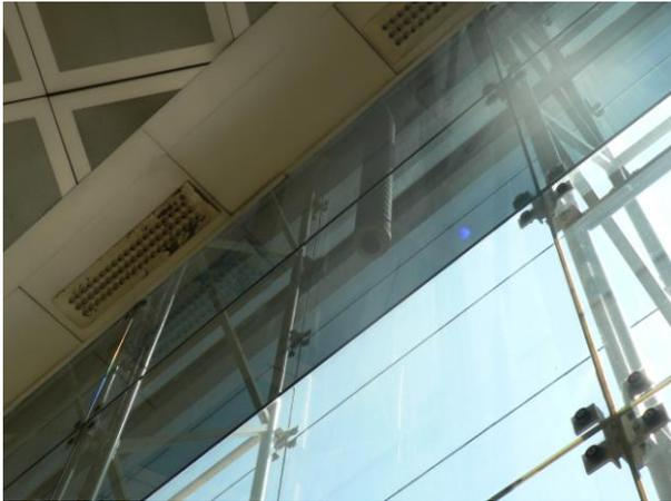
Fig. 43. Detalle de toberas en la doble piel de fachada del Aeropuerto de Barcelona anterior al actual.
