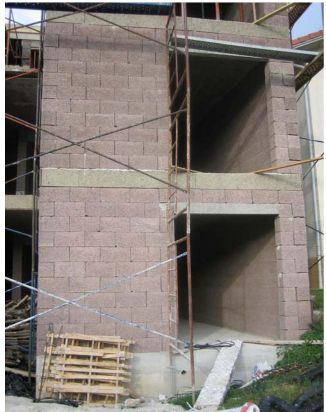
Fig. 36. Los cerramientos realizados con bloques conglomerados de residuos de madera reciclada alcanzan elevados rendimientos técnicos y ambientales. Muros realizados con CLIMABLOC.
