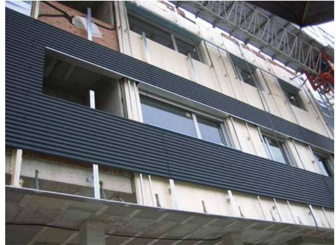
Fig. 40. La utilización de cerramientos opacos captadores de energía solar permiten reducir el consumo de energía en períodos fríos hasta en un 10% sin considerar diseños específicos y con un coste que es asumible sin tener en cuenta costes ambientales o análisis de ciclo de vida, por lo que se puede presuponer un campo de utilización creciente. Viviendas realizadas por el estudio del autor en Sarriguren, Navarra.
