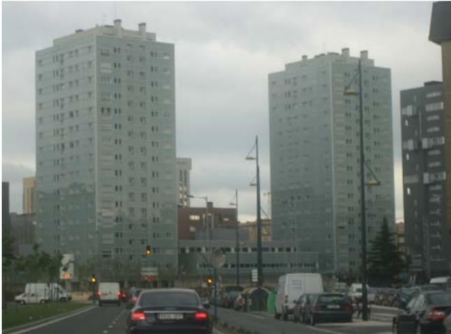
Fig. 39. La reducción relativa del precio del vidrio respecto a otros materiales está contribuyendo a la ampliación de su campo de utilización a cerramientos opacos, lo que proporciona la oportunidad de aprovechar sus propiedades como captador de energía solar. Viviendas en Vitoria.
