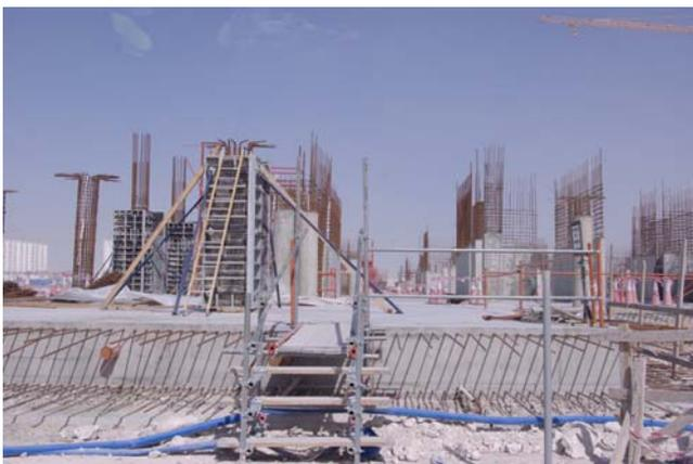
Fig. 30. El desconocimiento del comportamiento del terreno y otras incertidumbres, como las inconcreciones de los proyectos dan origen a sobredimensionamientos injustificados de los cimientos. En la imagen placa de cimentación superficial para un edificio de 3 plantas.
