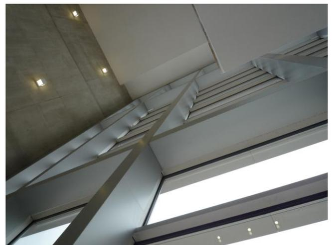
Fig. 61. Imagen interior del muro cortina de vidrios activos de cámara de agua desde el interior del vestíbulo del edificio. Figura extraída de: [http://www.intelliglass.es/index.php?option=com\\_content&view=article&id=118](http://www.intelliglass.es/index.php?option=com_content&view=article&id=118)
