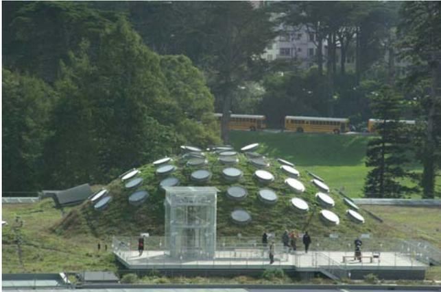
Fig. 43. En los ambientes urbanos, cuyas condiciones ambientales resultan afectadas por un metabolismo energético y de recursos muy desequilibrado la generalización de la utilización de cubiertas verdes podría contribuir a la ruptura de la espiral de aumento de demanda. En la imagen la cubierta del museo de la Academy of Science de California, de Renzo Piano.
