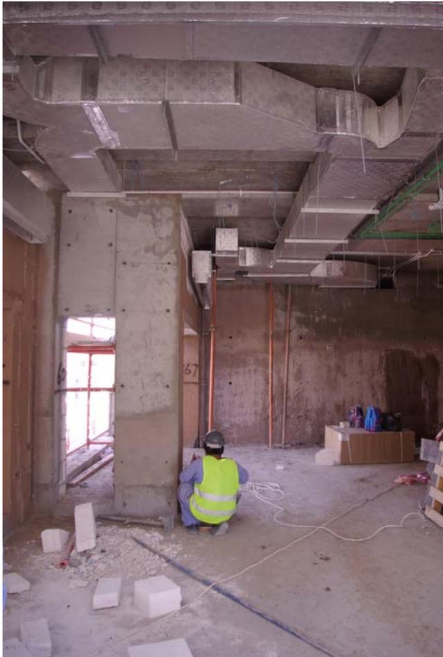
Fig. 48. Los sistemas de acondicionamiento deben adaptarse a cada caso. En la imagen ejecución del sistema de acondicionamiento en una vivienda situada en una región de clima extremado seco.
