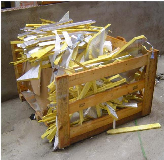
Fig. 32. La generalización de los semiproductos en primer lugar, y de los composites con ellos desarrollados en segundo lugar, ha dado lugar a una nueva generación de residuos que requieren atención especial en el tratamiento de los residuos a pie de obra. Fuente propia.
