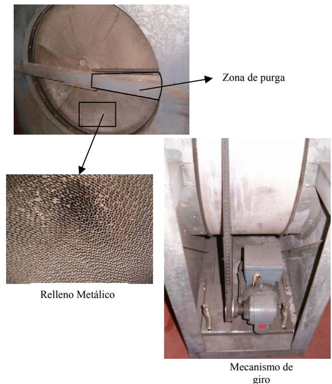
Fig. 7. Recuperador rotativo y elementos.
