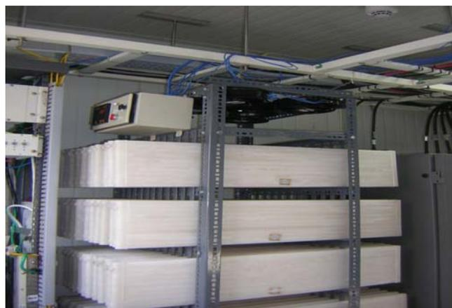
Fig.6. Casetas de equipamiento electrónico en India. Los contenedores blancos que se pueden ver en la imagen se encuentran rellenos con PCM. Su función es evitar sobrecalentamientos en el caso de que ocurra un corte prolongado en el suministro eléctrico, los cuales no son infrecuentes. (Imágenes e información: <http://pcmenergy.com>)
