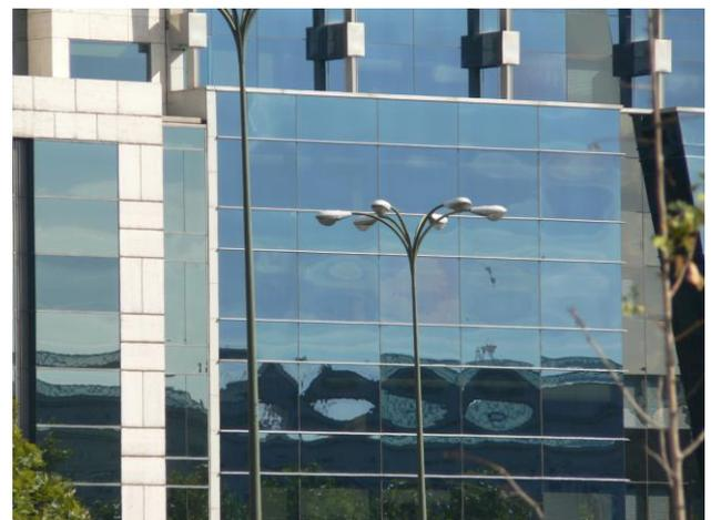
Fig. 54. Aspecto de un acristalamiento sometido a los efectos de las presiones "isócoras" en su cámara.
