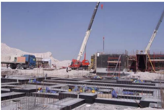
Fig. 33. Una de las causas del sobredimensionamiento de los cimientos es el uso de material auxiliar adecuado. En la fotografía, cimientos de edificios ejecutados con las dimensiones adecuadas mediante la utilización de encofrados.
