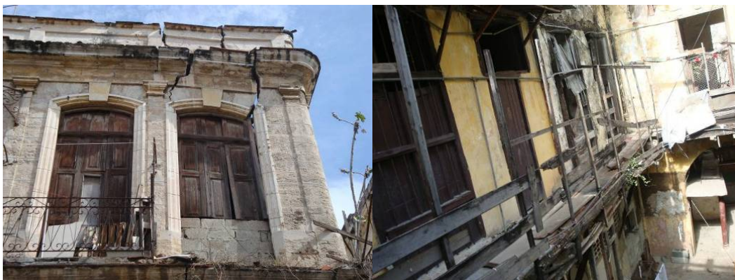
Figura 2: Acciones de emergencia (Reconstrucción respectiva de arco y pasillo de circulación)
