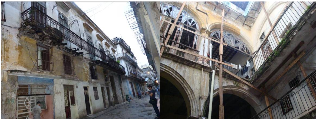
Figura 1: Edificios deteriorados en el Centro Histórico de La Habana
