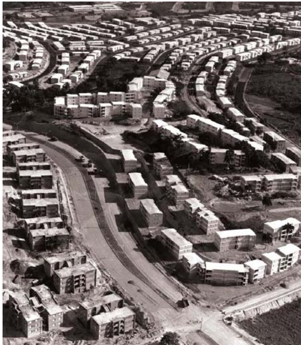
Fig. 7: Bloques de viviendas construidas por el Gobierno de Balaguer.
