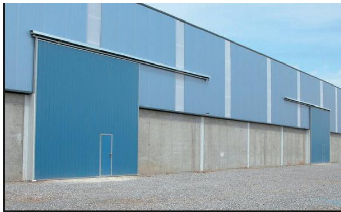
Fig. 3.4: Ejemplo puerta metálica corredera en el exterior de la nave.
