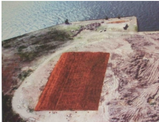
Trabajos de preparación del terreno.
