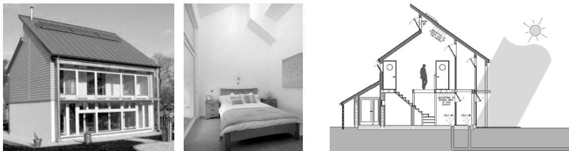
Figura 2.35. Imágenes de la Casa BASF. Derecha a izquierda: Imagen del exterior, cuarto principal y sección con el intercambiador tierra-aire [RODRIGUES, GILLOTT 2011].
