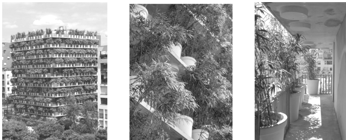
Figuras 9.7. Utilización de macetas de bambú como argumentación estética y protección solar. Tower Flower. Paris 17. Edouard François arquitecto [ http://www.edouardfrancois.com ]
