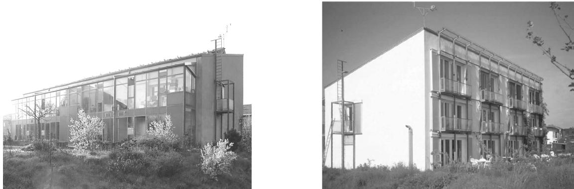
Figura 2.5. La primera vivienda con estándar Passivhaus en Darmstadt-Kranichstein. Arquitectos Bott/Ridder/Westermeyer, diseño energético W. Feist y B. Adamson [PASSIVHAUSTAGUNG.DE].
