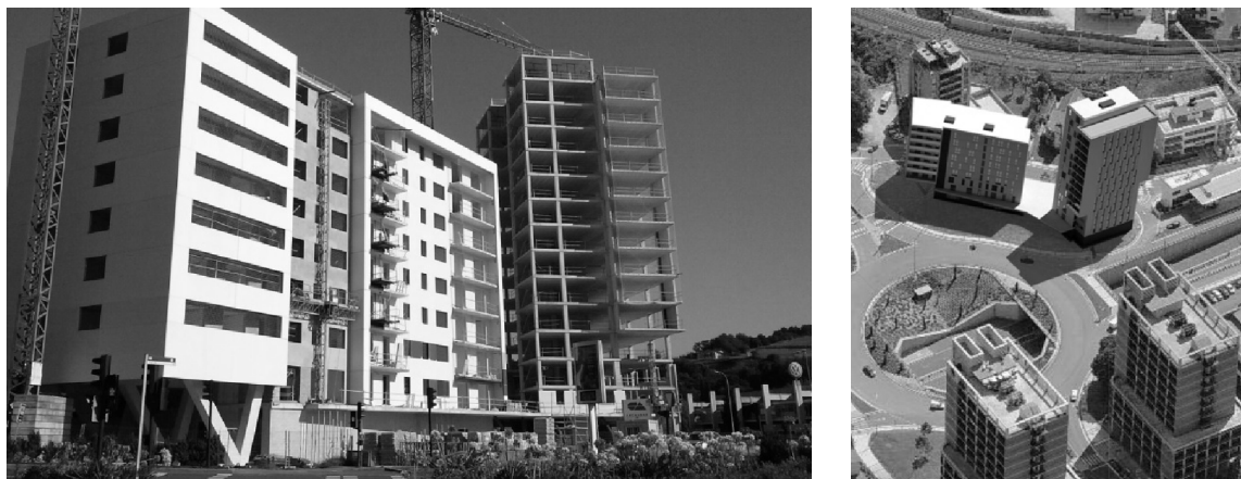
Figura 4.10. Imagen de la construcción de un edificio de VPO con las técnicas habituales, estructura porticada de hormigón armado y fachada de paneles prefabricados. Izquierda, imagen del exterior en obras; derecha, imagen aérea de la promoción. La torre se corresponde con las viviendas VPO y el edificio bajo con las viviendas tasadas. 75 Vpo + 25 Vpt, Locales, Garajes y Anejos en la Parcela Ib.18.1 "Amerika Plaza" para Etxegintza (Empresa Municipal de la Vivienda Donostia-San Sebastián), Donostia-San Sebastián. Estudio Ugari, José Javier Uranga y Patxi Gastaminza arquitectos. Imagen del autor y Etxegintza [ www.donostia.org ].
