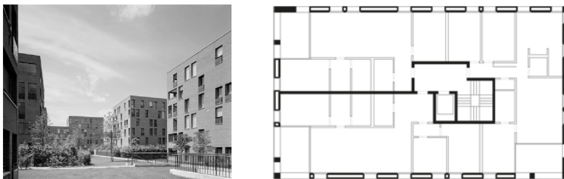
Figura 4.1. Viviendas en Ruggächern, Zúrich. Arquitectos Baumschlager&Eberle. Arquitectos: Baumchslager&Eberle [www.baumschlager-eberle.com]
