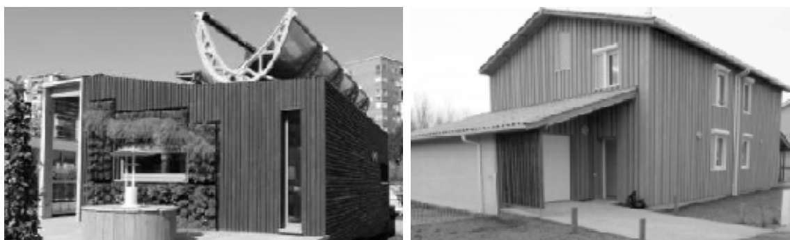
Figura 2.36. Vivienda experimental Navepomo, vivienda bifamiliar en Taillan-Medoc y vivienda en Arrousets [DECKER et ál. 2011].
