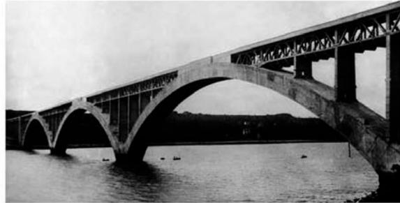
Fig.06 Eugène Freyssinet. Puentes de Villeneuve sur Lot (1914); Saint Pierre du Vouvray (1922); Plougastel: traslado de la cimbra y puente terminado (1925).
