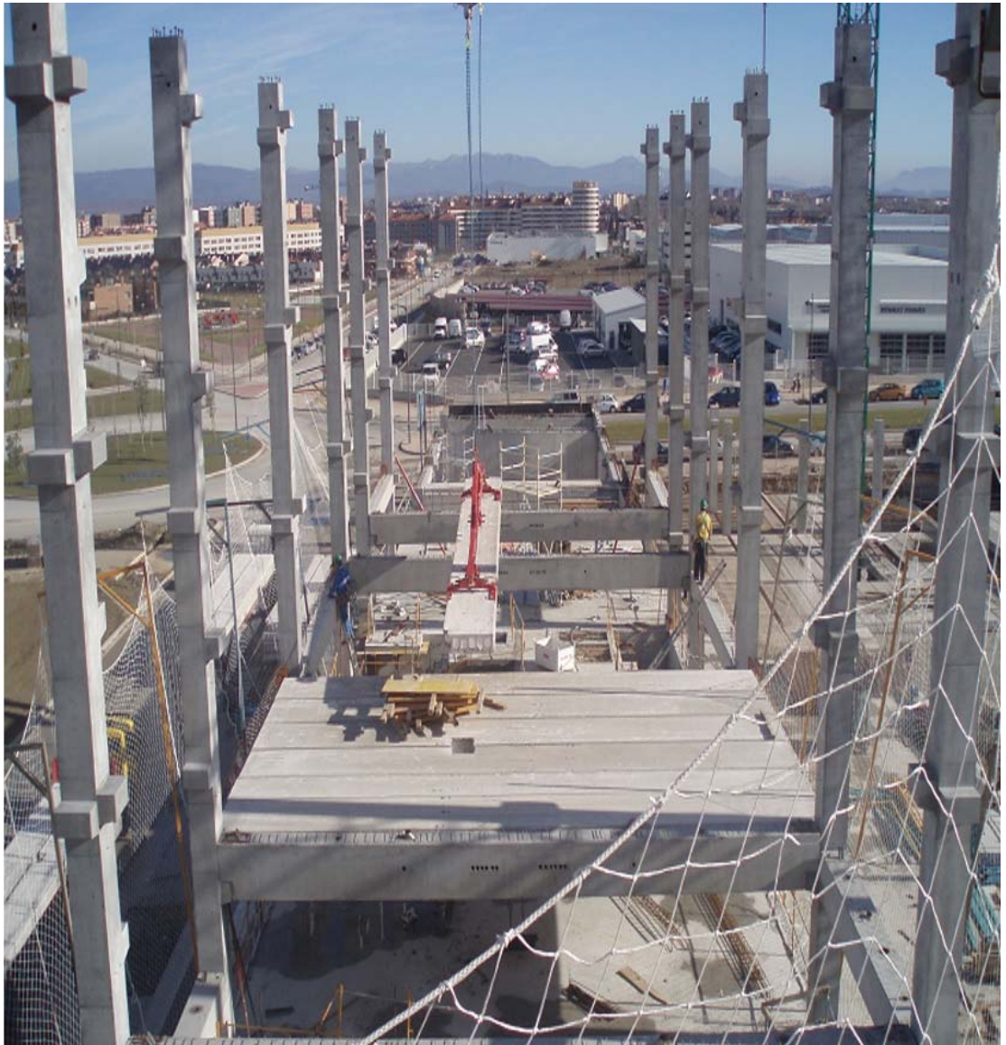
PICH-AGUILERA, 156 VIVIENDAS EN ZABALGANA. VISTA EN CONSTRUCCIÓN xiv
