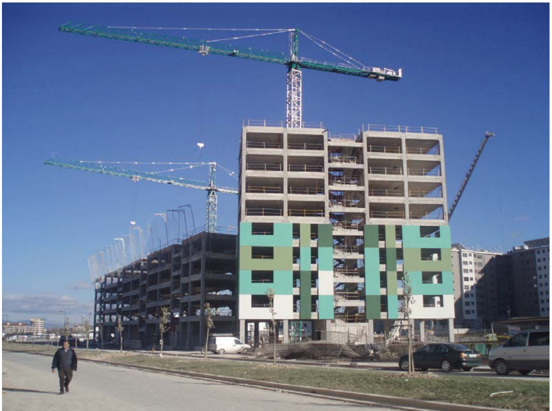
PICH-AGUILERA, 156 VIVIENDAS EN ZABALGANA. VISTA EN CONSTRUCCIÓNx
