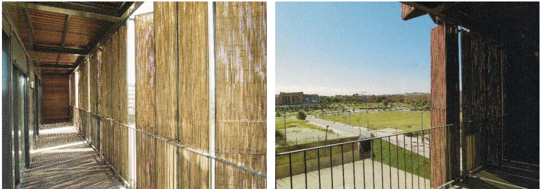
88 VIVIENDAS EN CARABANCHEL. APERTURA PARCIAL O TOTAL DE TERRAZAS. DOBLE ORIENTACIÓN Y ESPACIO VERDE PRIVADO v
