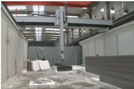
IMPRESORA 3D DE WINSUN, realizando un muro portante lvi
