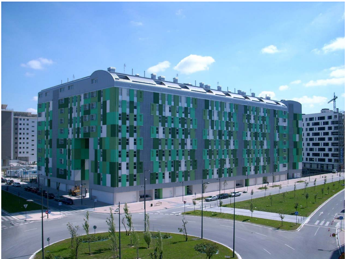
PICH-AGUILERA, 156 VIVIENDAS EN ZABALGANA. VISTA EXTERIOR DEL EDIFICIO TERMINADO xii
