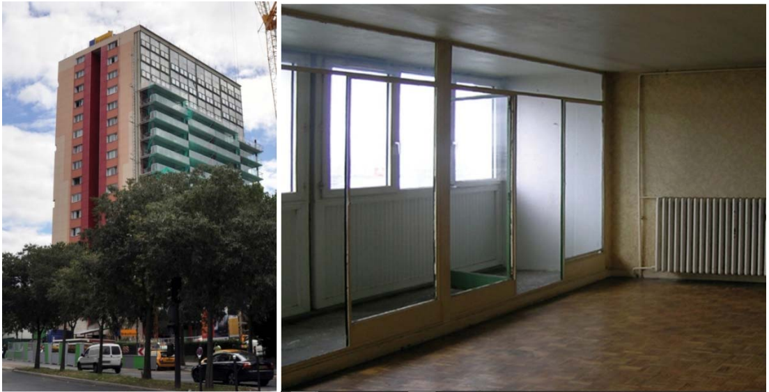
TRANSFORMATION DE LA TOUR BOIS LE PRETRE - PARIS 17 e - DRUOT, LACATON & VASSAL. Proceso de obra, con los vecinos dentro. A la derecha, interior antes de la intervención lxi
