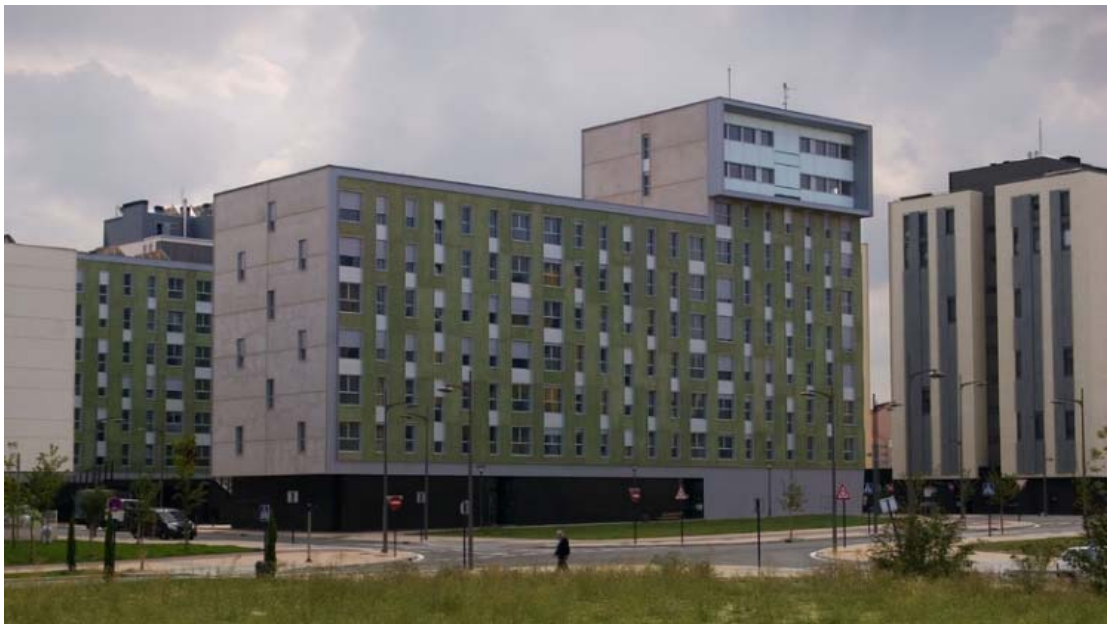
VISTA EXTERIOR DEL EDIFICIO iii
