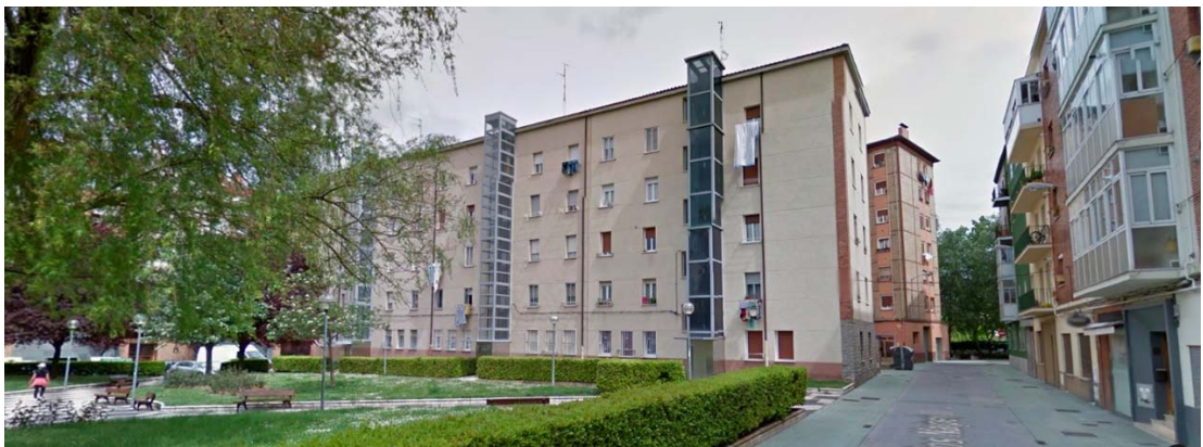
INCORPORACIÓN DE ASCENSORES Y ENSANCHAMIENTO DE FACHADAS, OCUPANDO EL ESPACIO PÚBLICO, EN VITORIA xxx
