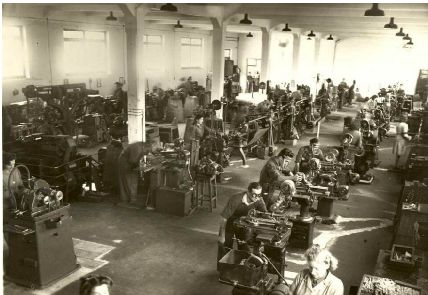
LABORDE FONDOA 63XXX01. Lantegiko barruko aldea. Hennebique sistema ikus daiteke, zutabeak, habeak, lotzeko korapiloak eta lauza nerbioduna. Atzekaldean erreminta gela.
