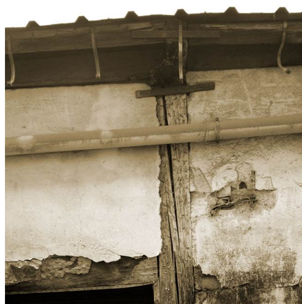
Egileak ateratako argazkiak. Bertan eraikinaren xehetasun ezberdinak ikus daitezke: arotzeria metalikoa; zurezko zutabea eta estalkiaren arteko lotura; zutabea horman sartuta; horma kanpotik ikusita zurezko zutabe eta leihoburuarekin, estalkiaren egitura eta estalkiko txapa.
