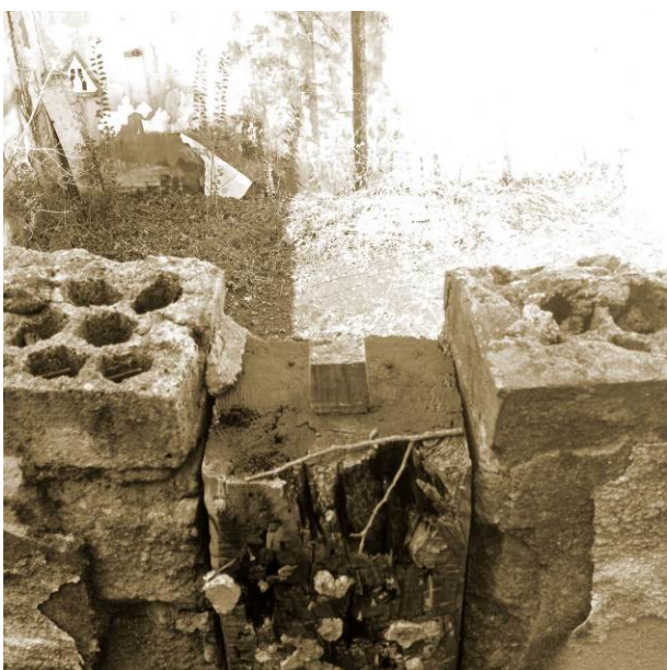
Egileak ateratako argazkiak. Bertan eraikinaren xehetasun ezberdinak ikus daitezke: arotzeria metalikoa; zurezko zutabea eta estalkiaren arteko lotura; zutabea horman sartuta; horma kanpotik ikusita zurezko zutabe eta leihoburuarekin, estalkiaren egitura eta estalkiko txapa.
