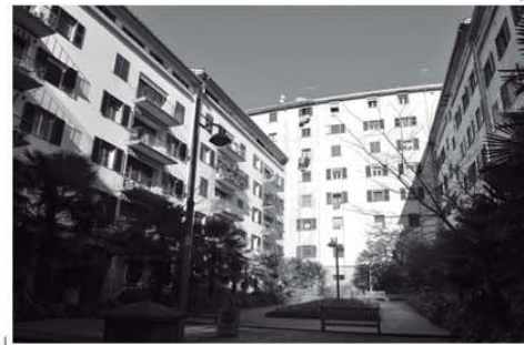
eib.1 VIVIENDAS ENTRE CALLES MÁRIA ÁNGELA Y BIDEBARRIETA Joaquín Domínguez, José Antonio Ponte / DGRDR
