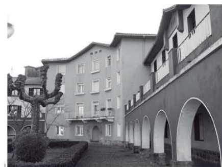
zes VIVIENDAS PROTEGIDAS CONTRUC. NTRA SRA DE ARANZAZU Felix Llanos, Luis Alustiza / Construc. Asistencial Ntra Sra de Aranzazu
