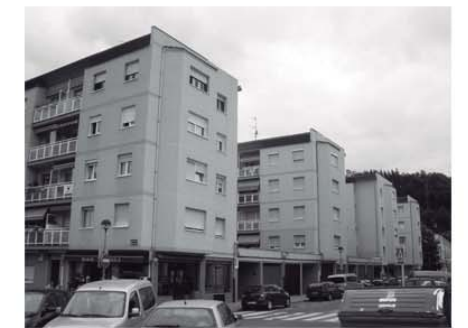
are.2 VIVIENDAS Y LOCALES PARA CONSTRUCTORA ARIAZAR S.A. Luis Alustiza / Construcciones Ariazar S.A., OSHA
