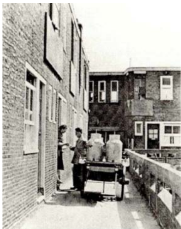
Fig. 2.23. Calle o pasarela intermedia que recorre todas las fachadas interiores de la manzana.
