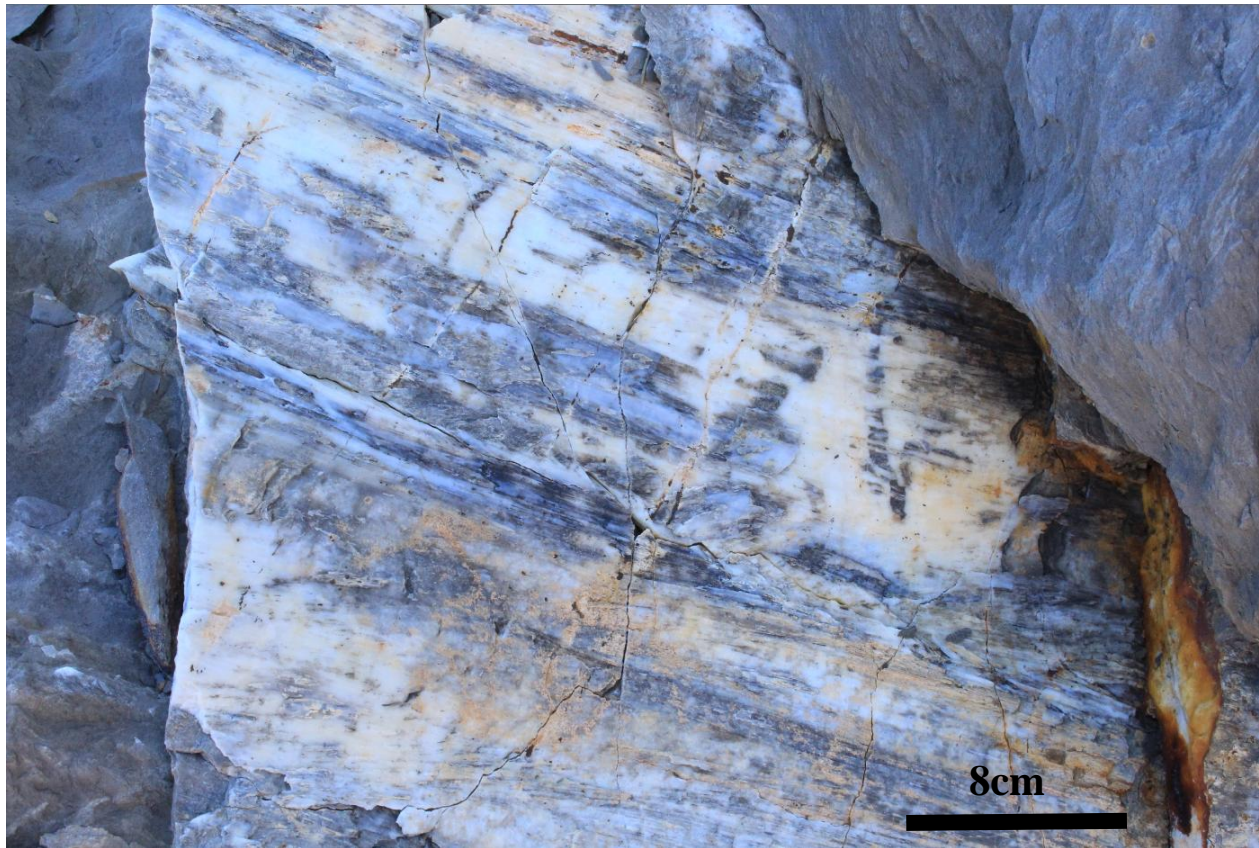
Foto 8. Superficie de falla con estrías.
