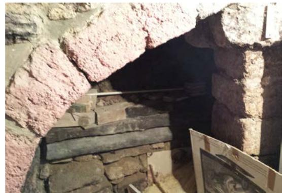
Figura 57 - Pilar sosteniendo arco - (Fuente: *Elaboración propia, 2016*)
