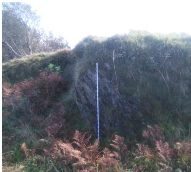
(Figura 9). Corte efectuado para hacer el foso en la unión de los brazos sur y oeste (fotografía del autor).
