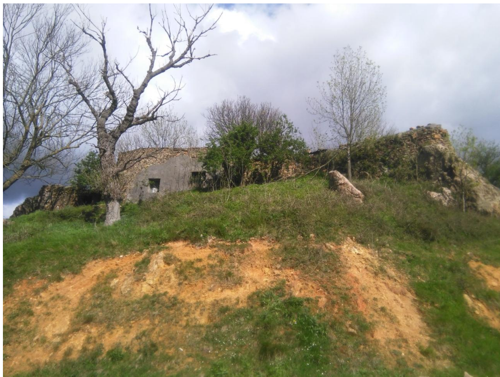
(Figura 45). Exterior de la fachada oeste (fotografía del autor)..
