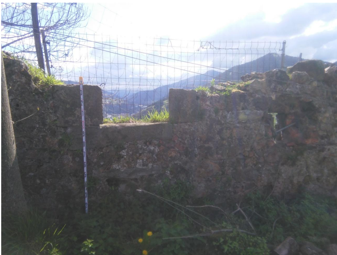
(Figura 47). Recinto superior de la fachada sur. Al fondo el valle del Cadagua (fotografía del autor).
