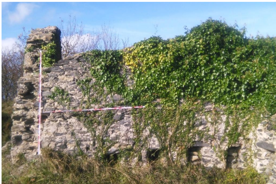
(Figura 5). Alzado oeste del brazo norte. La mira estadimétrica horizontal marca la cornisa que separaría dos pisos diferentes (fotografía del autor).
