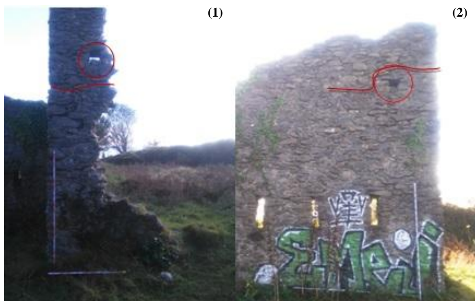
(Figura 6). Vista exterior de los brazos oeste (1) y sur (2), se observan en su parte superior dos de las aberturas que hemos interpretado como mechinales y los cambios en el aparejo del muro a la misma altura (fotografías del autor).
