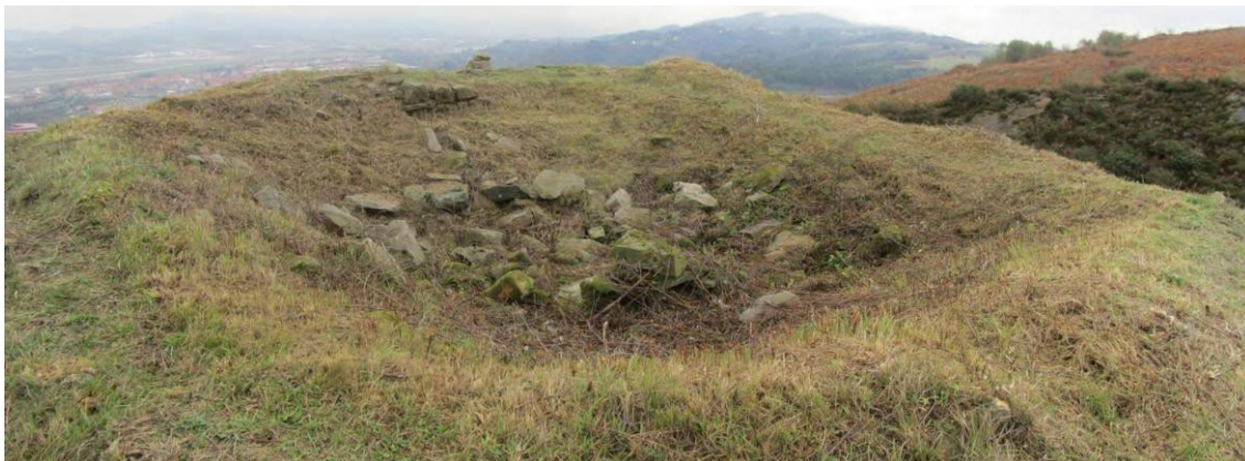
(Figura 35). Derrumbe al interior de la torre (TELLERIA, 2014).
