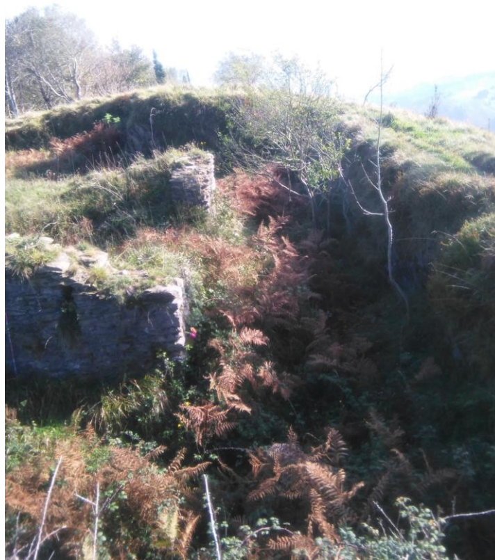
(Figura 32). Foso en la fachada sur (fotografía del autor)..
