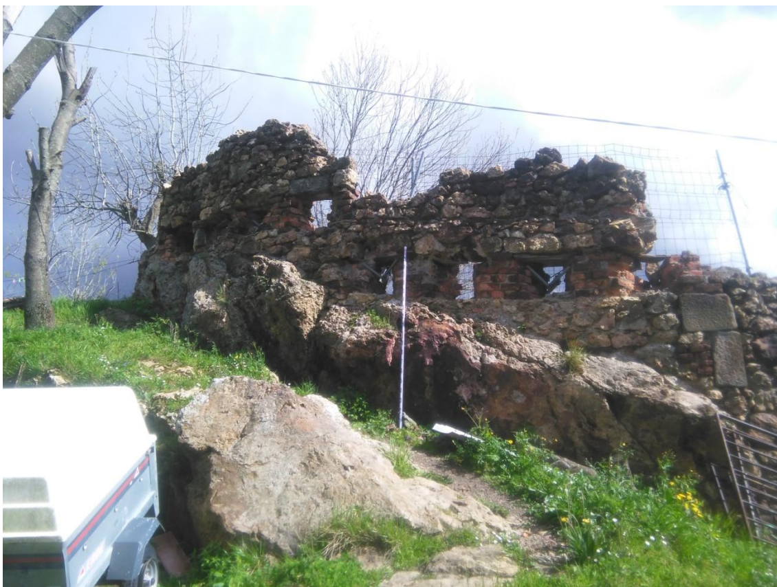
(Figura 48). Interior de la fachada sur (fotografía del autor).
