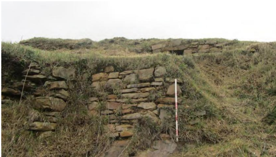
(Figura 36). Alzado norte de la torre (TELLERIA, 2014).
