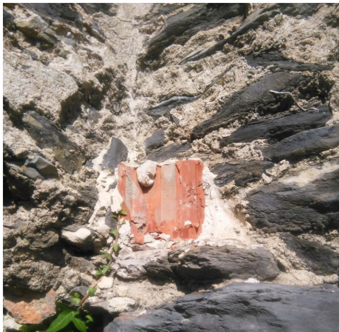
(Figura 29). Detalle del brazo oeste donde se observa restos de consolidación (fotografía del autor).
