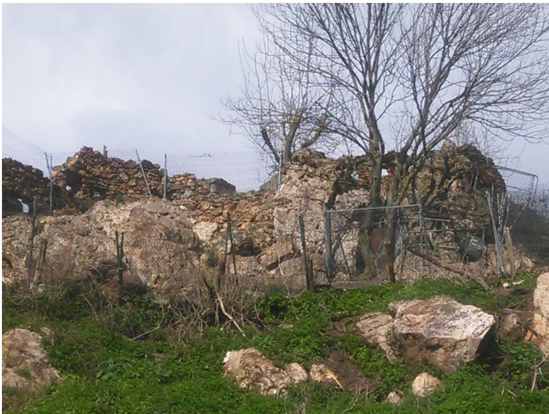
(Figura 44) Exterior de la fachada sur (fotografía del autor).
