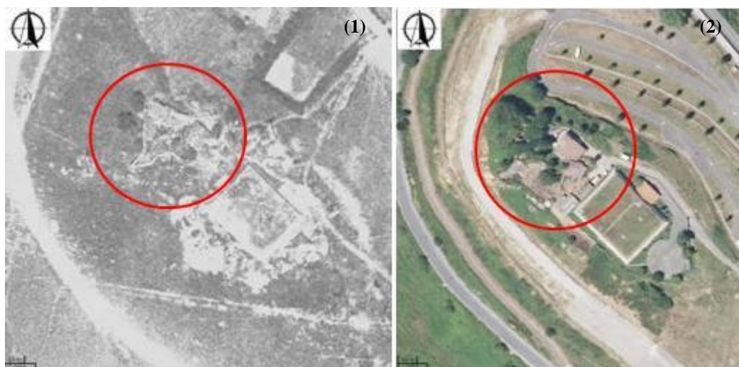
(Figura 19). Ortofoto del vuelo de la Diputación de Bizkaia de 1965 (1) y del GV de 2015 (2) ( GeoEsukadi ). Entre ambos se evidencia la cubrición vegetal del elemento.
