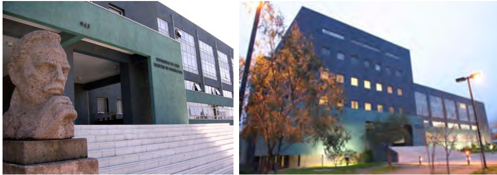
Figura 5. Edificio principal de la actual Facultad de Odontología Universidad de Chile.
