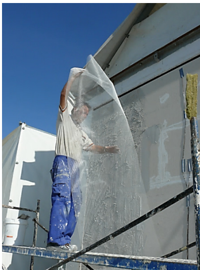
5.14 Irudia – Azkeneko estaldura motrailu, maila eta emokadura harrizkoarekin
