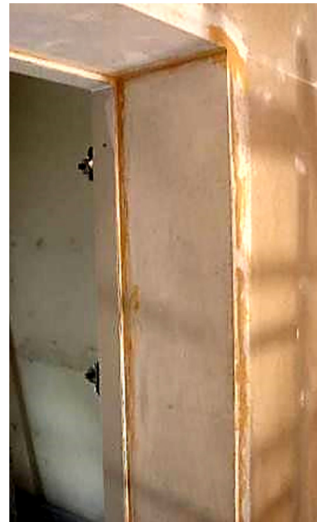
1.5 Irudia – Entsegu gelaren itxituren lehenengo zur xafla kapa eta sarbide-atea jartzea, eta juntura-zigilatzearen xehetasuna
