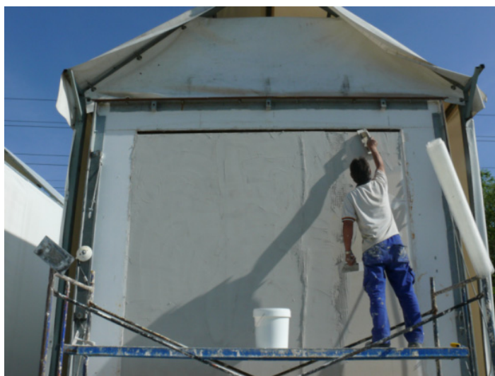
5.14 Irudia – Azkeneko estaldura motrailu, maila eta emokadura harrizkoarekin
