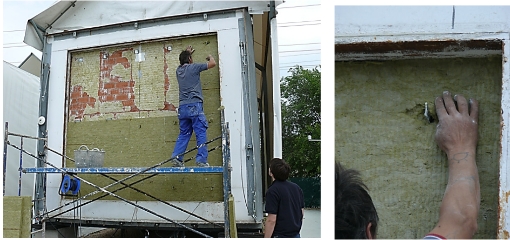
4.11 Irudia – Haitz-artilearen jartzea eta isolamendu-kapako ainguraketa puntualen sartzearen xehetasuna
