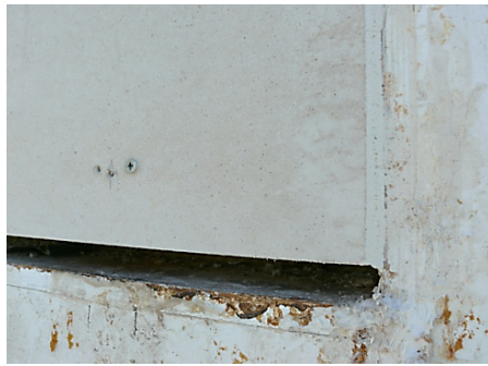
4.13 Irudia – Kanpoko orriaren juntura zigilatzea eta aire-sarrera xehetasuna
