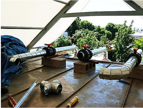
4.42 Irudia – Aireztatutako ganberaren behartuaren erauzketa sistema
