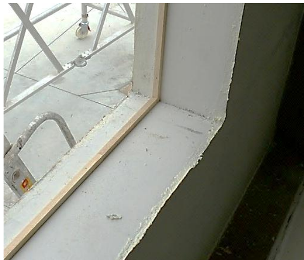
3.11 Irudia – Horma opakuko zuloko kanpoko aurpegiaren arrasean leihoaren jartzearen xehetasuna
