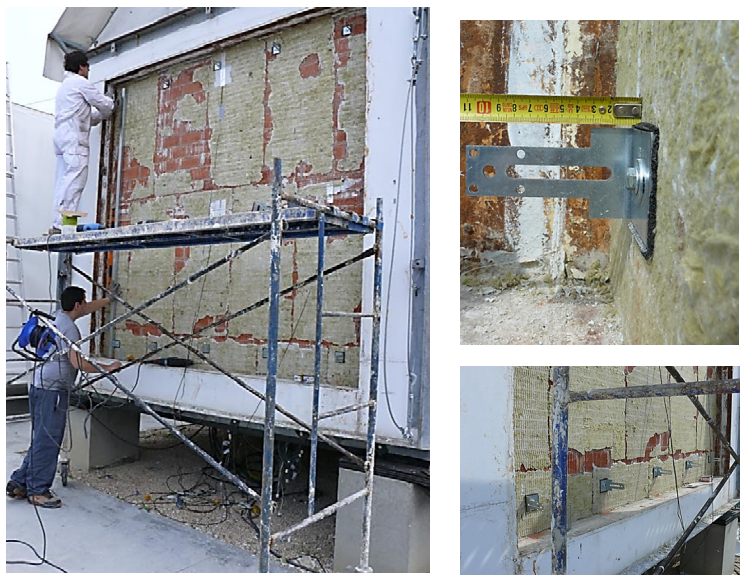
4.10 Irudia – Adreilu hormaren gaineko ainguraketa puntualen jartzea
