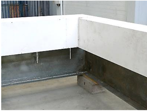
1.29 Irudia – Aurremarko metalikoaren barneko aurremarko isolatzailearen muntaketa prozesua eta juntura-zigilatzea
