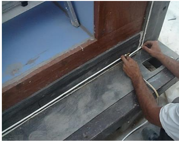
1.30 Irudia Zeldaren egiturako zigilatze junturak eta lagin-garraiatazaillearen ainguraketa bernoen xehetasuna
