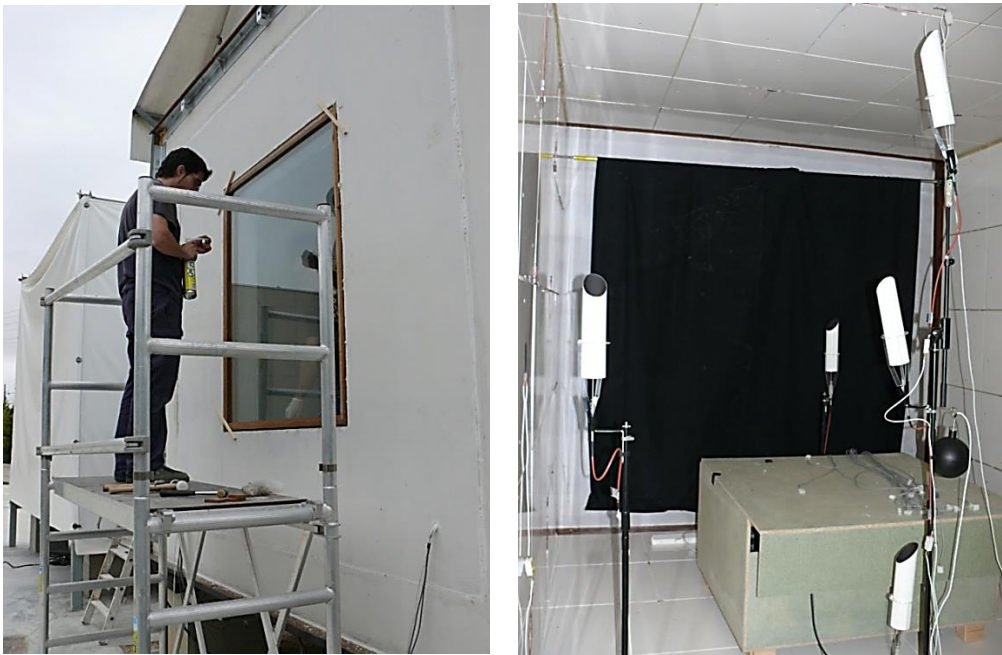
3.12 Irudia – Junturen kanpoko zigilatzea, ezkerrean, eta barruko aurpegian errezelaren, eskuinean
