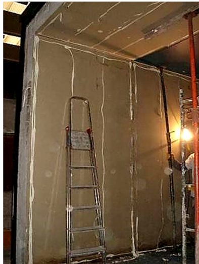
1.5 Irudia – Entsegu gelaren itxituren lehenengo zur xafla kapa eta sarbide-atea jartzea, eta juntura-zigilatzearen xehetasuna
