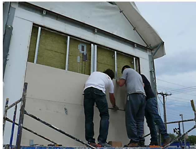
4.21 Irudia – Aireztatutako ganbera eratzten duten azaleretako zundetako antolamenduaren adibidea, goiko irudia, eta sentsoreen instalazioaren xehetasuna, beheko irudia
