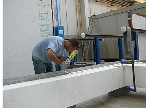
1.29 Irudia – Aurremarko metalikoaren barneko aurremarko isolatzailearen muntaketa prozesua eta juntura-zigilatzea
