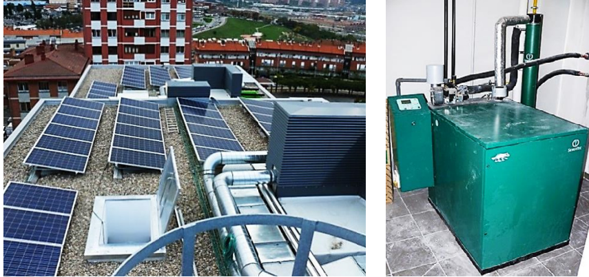
Figura C.18 – Sistemas de generación eléctrica
