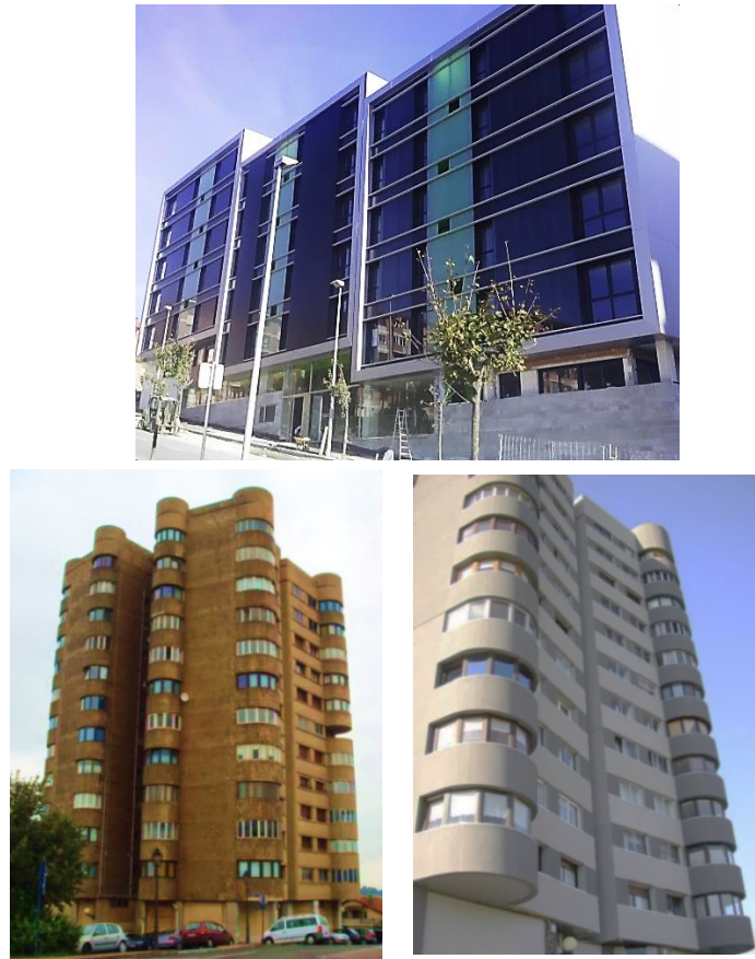
Figura I.1 – Ejemplos de soluciones de envolvente con fachada ventilada para obra nueva, imagen superior, y en rehabilitación, imágenes inferiores
