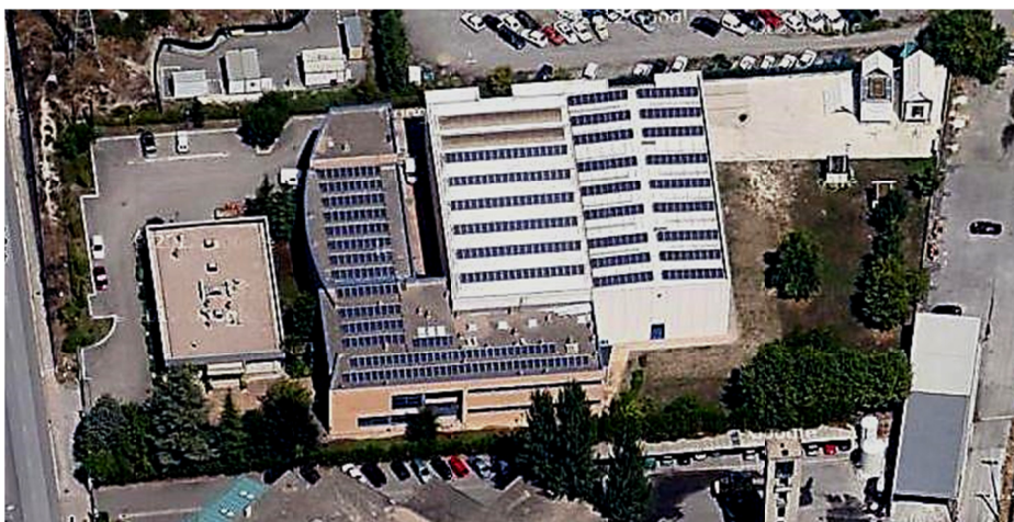
1.11 Irudia – ERKL-aren instalazioak Gasteizean
