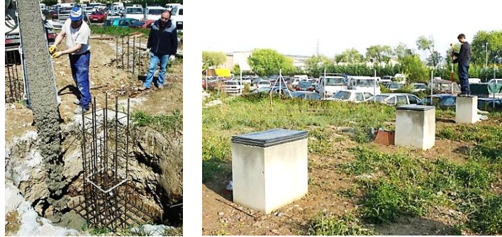
1.14 Irudia – Zimenduen eraikuntza eta zelden euskarri diren zutabeen orientazioaren egiaztatzea
