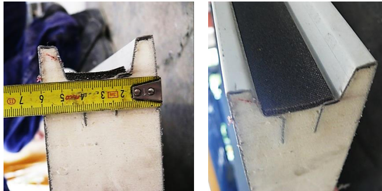
4.36 Irudia– Panel sandwichetako zubi termikoko hausturaren xehetasuna
