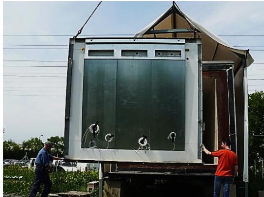
4.44 Irudia – Fatxada behartuaren azkeneko muntaketako prozesua
