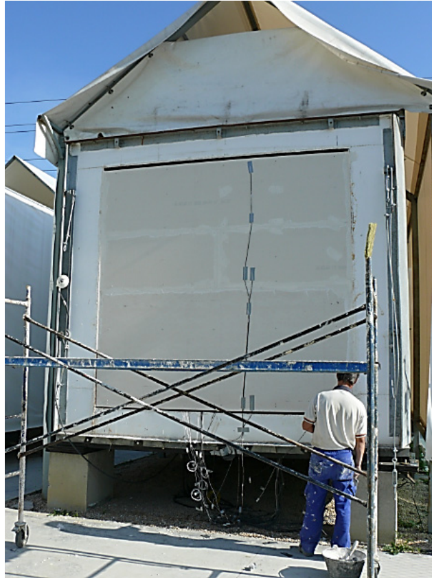
4.13 Irudia – Kanpoko orriaren juntura zigilatzea eta aire-sarrera xehetasuna
