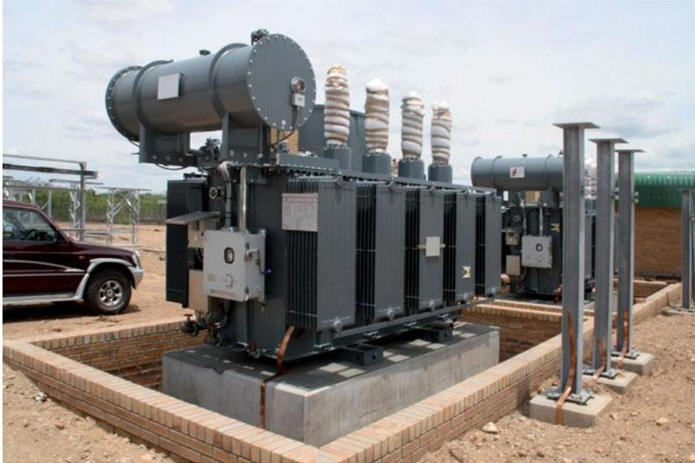
*Ilustración 2.6-6 Transformador en baño de aceite*
