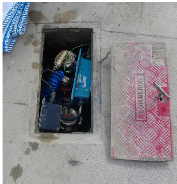
Ilustración 32. Colocación del datalogger en una arqueta
