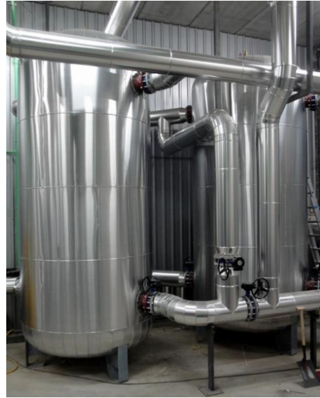
Ilustración 27- Depósitos de inercia
