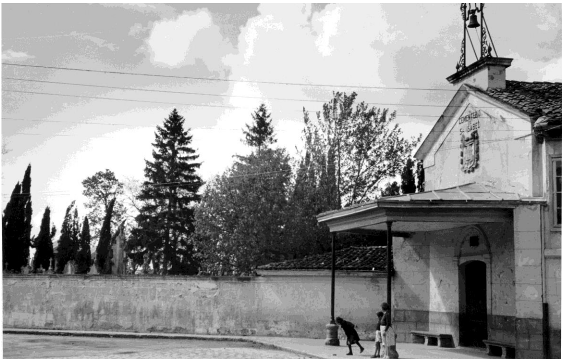
Fig. 11. La reformada capilla de santa Isabel entre los años 1940 y 1960. Foto: ATHA DFA.
