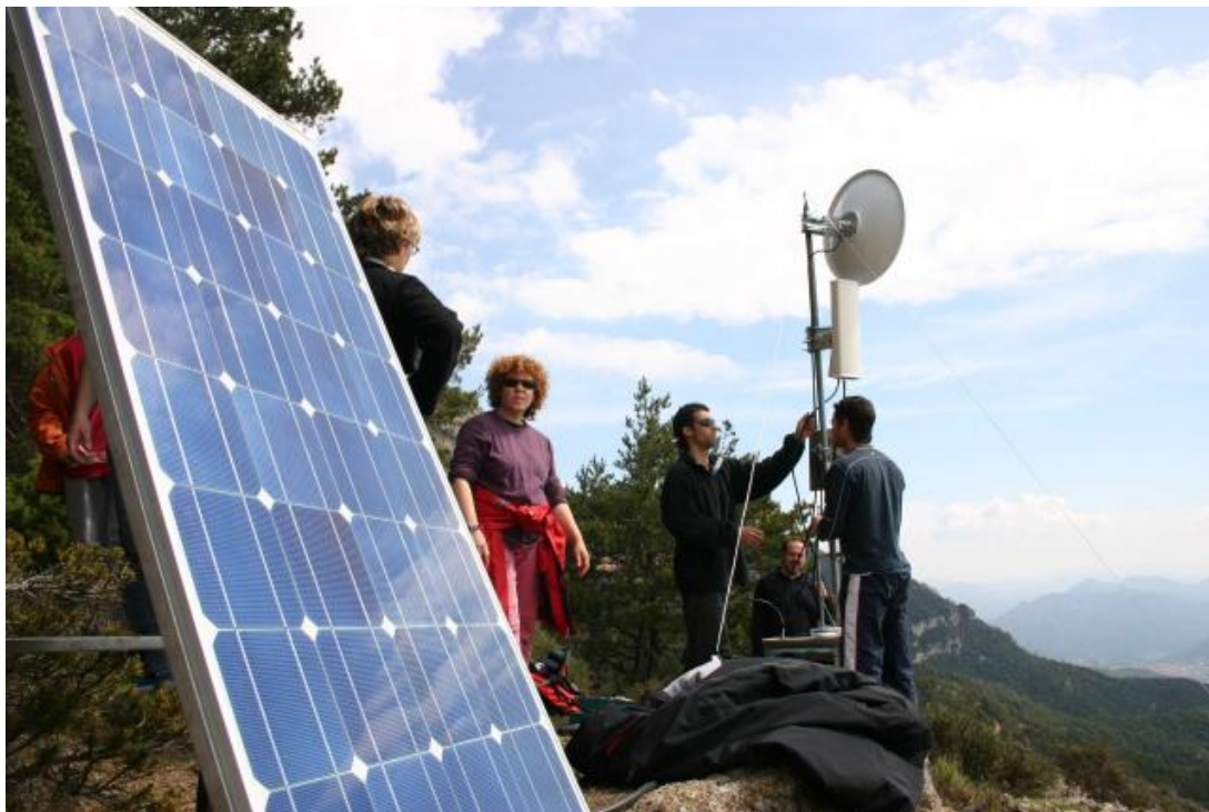
Figura: 3.12. Supernodo de guifi.net alimentado por energía solar.
