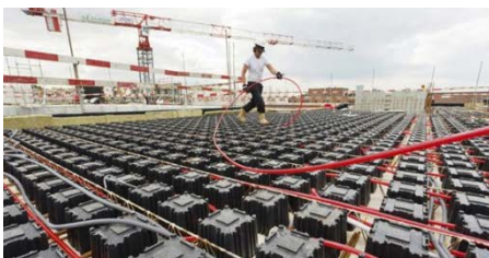
2.4 Irudia. Aire kutxak dituen TABS egituraren prestaketa eta horren eskema
