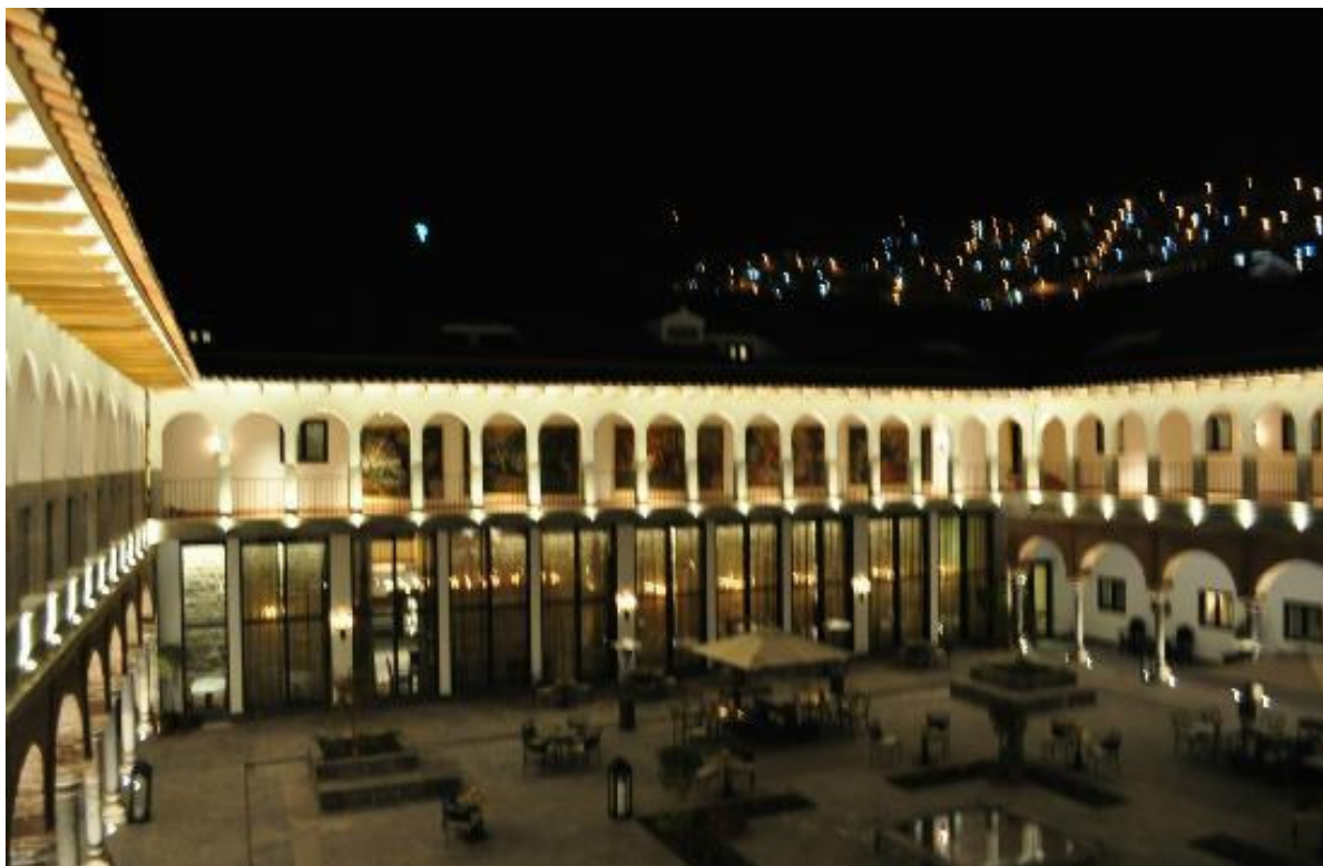
Deformación de las características tipológicas originales de las arquerías.
