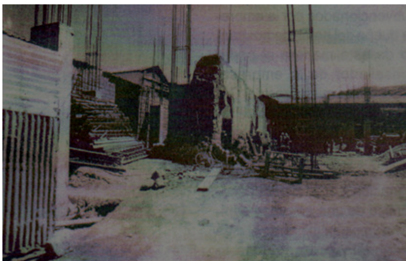
Pared colonial con bases incas, las mismas que, pese a la recomendación del informe arqueológico fue destruida íntegramente.
