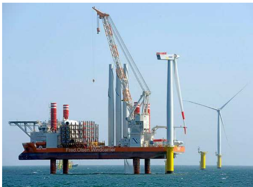
Imagen. Barco-plataforma de montaje de aerogeneradores marinos.
