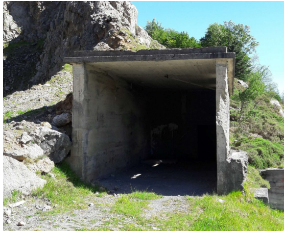
Figura 4. Cubierta almacén explanada Atxa Txiki.
