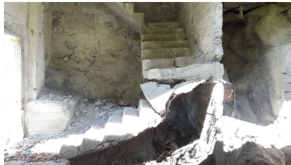
Figura 7. Escalera interior estructura principal Atxarte.
