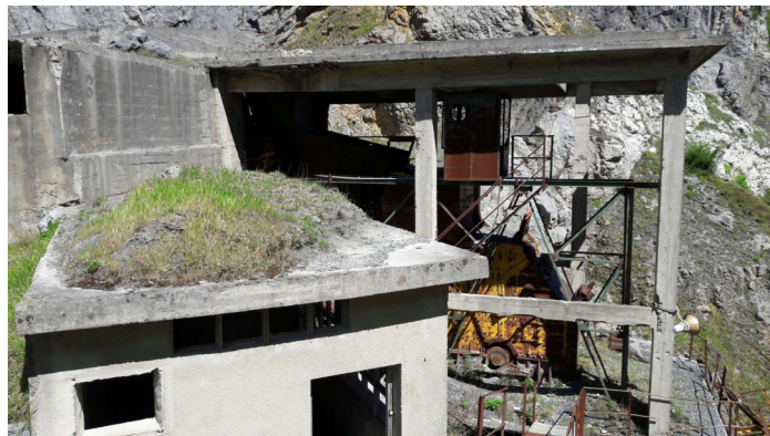
Figura 5. Cubiertas estructura principal Atxarte.
