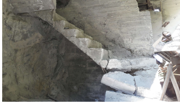
Figura 6. Escalera interior estructura principal Atxarte
