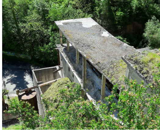
Figura 3. Cubierta estructura principal Atxa Txiki.
