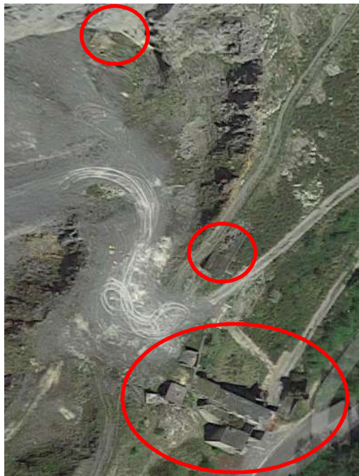
Figura 1. Estructuras Atxa Txiki.
