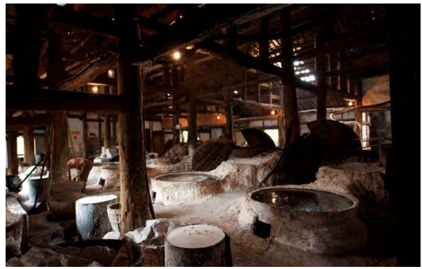
Figura6: Nave creada siguiendo la arquitectura de entramado China
