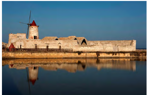
Figura6: Molino de bombeo en desuso, y almacenes.
