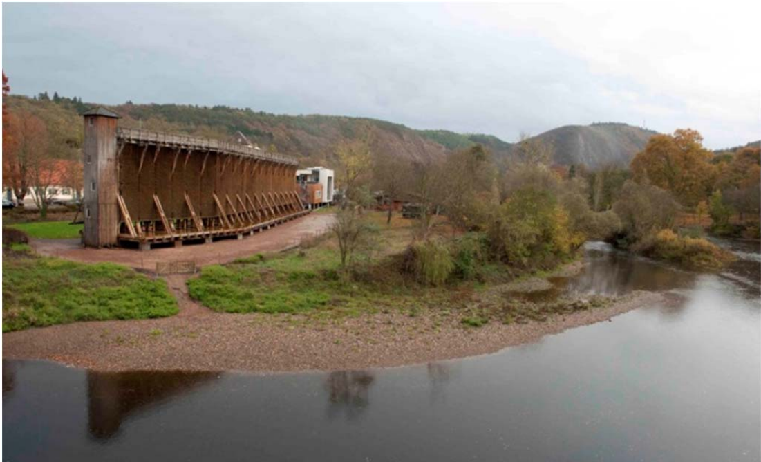
Figura 6. Imagen de un gradierwerke utilizado para la concentración eólica de la salmuera. Esta descende a través de las ramas para ser recogida en el interior de la estructura. En la actualidad se utilizan con fines balneario-medicinales. Bad Kreuzbnah, Alemania. Autor: Mikel Landa 11 .
