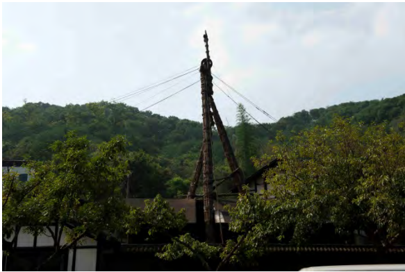
Figura3: Torre de bombeo en el pozo Shenhai
