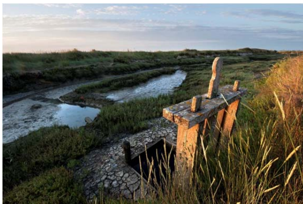
Figura 26. Compuerta que controla la entrada de agua de mar en el circuito de evaporación sobre el dique que separa la salina del mar en Les Marais Salant de Guérande., Francia
