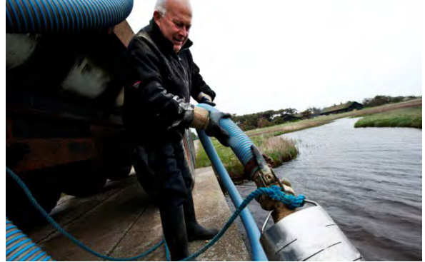
Figura 4: Bombeo de la salmuera a los tanques, para su transporte a la salina.
