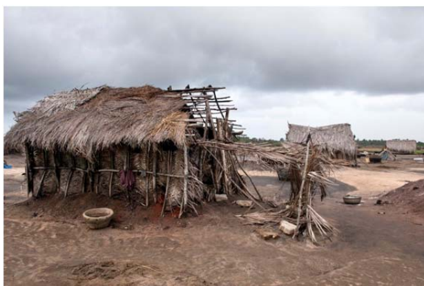
Figura 33. Edificios en los que se realiza la evaporación de la salmuera en Ouidah, contruidos con plaos y hojas de palma en las marismas de Djegbadji, Benin.
