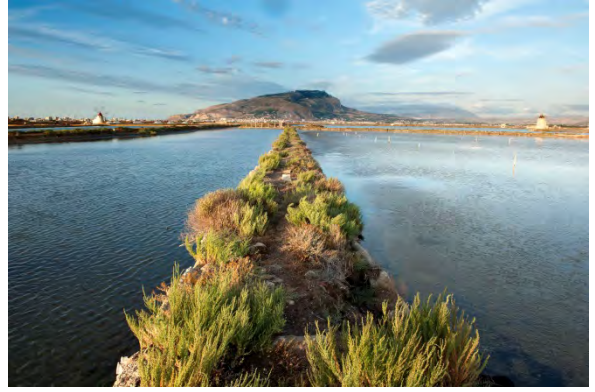
Figura4: Muro separando el mar, a la izquierda, del pozo concentrador.
