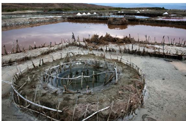
Figura 25. Pozo y de evaporación en Anse Rouge, Haití. Los únicos materiales utilizados para la construcción de los muros que componen la salina son la arcilla y palos de madera atados con cuerdas.
