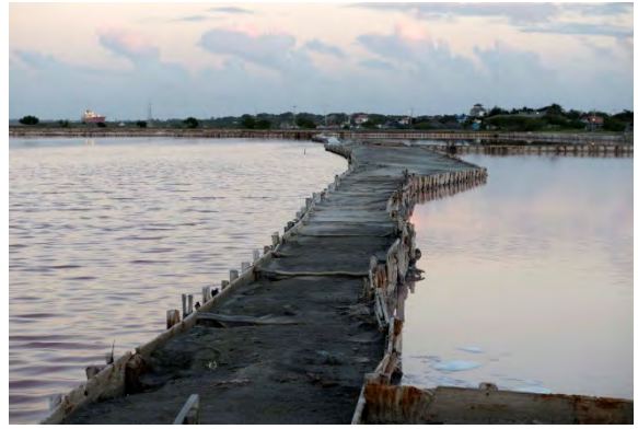
Figura4: Muros de arcilla contenidos con entramado de madera
