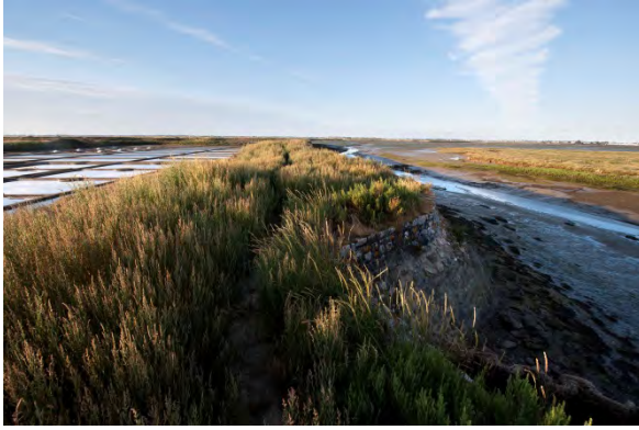
Figura3: Muro de contención marea-salina
