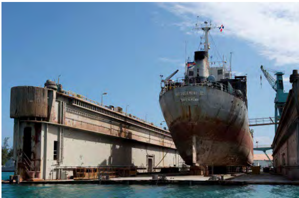
Figura 15: Instalaciones para la reparación de barcos en la bahía
