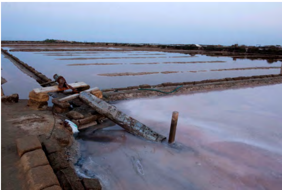
Figura 7: Tornillo de Arquímedes, para el bombeo de la salmuera.
