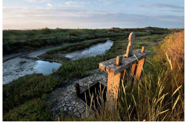
Figura4: Compuerta de entrada de agua de mar al circuito.
