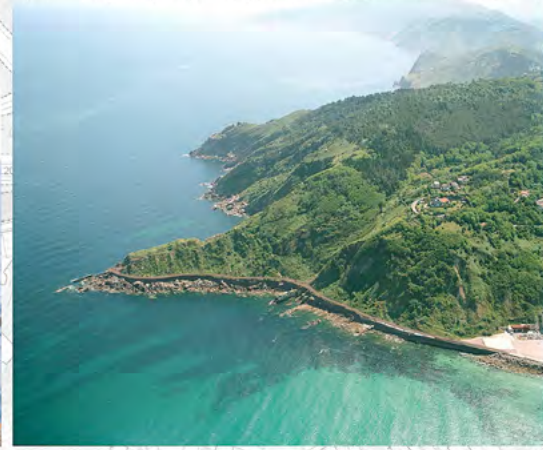
Montaje Proyecto pasarela Mompas 2008
