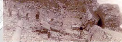
Rotura del muro
