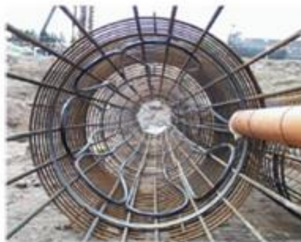
Ilustración 6: Cimentación para explotación profunda
