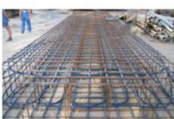
Ilustración 7: Cimentación para explotación superficial
